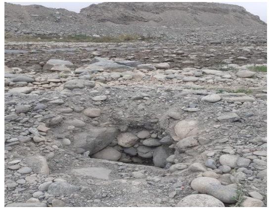
Fotografía 10. Excavación de calicata
