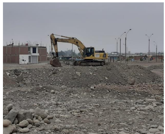
Fotografía 12. Zona afectada en reconstrucción.
