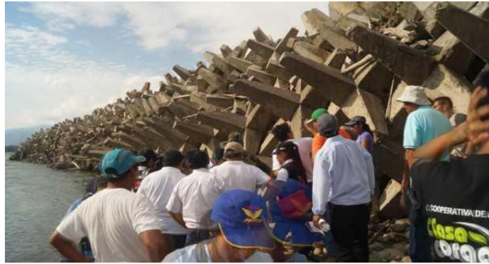
Figura 11. Se muestra la defensa ribereña con bloques de concretos llamados hexápodos . (fuente: Inforegion, 2013)
