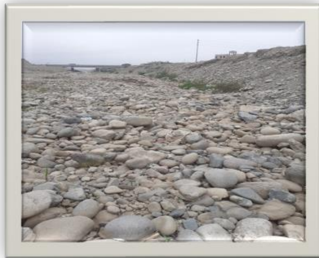
figura 25. Rocas para relleno de los gaviones.
