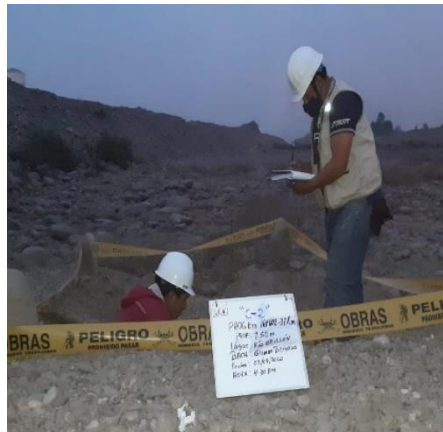
Fotografía 2. Excavación de la calicata 2
