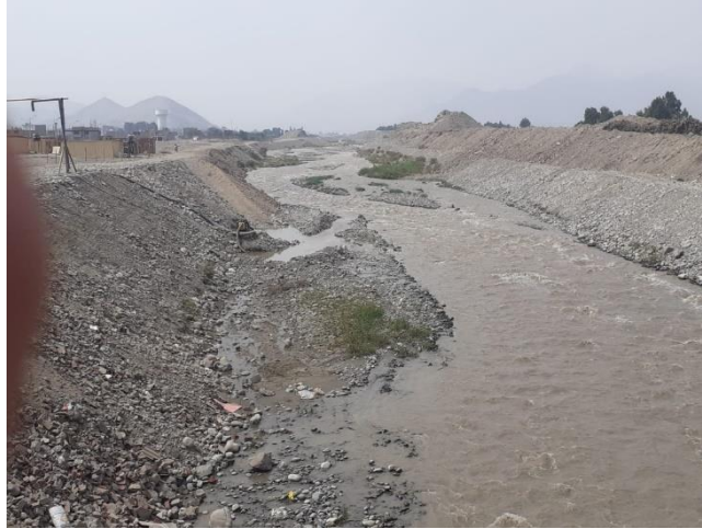
Figura 3. En la actualidad la zona afectada se ha colocado como una especie de dique de material suelto (fuente: propia, 2021).
