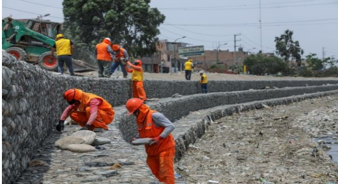
Figura 7. Rio chillón, 1460 metros construidos con gaviones en el límite de Puente Piedra con san Martín. (Fuente: municipalidad de Lima, 2018)
