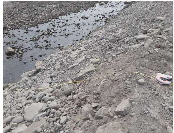
Fotografía 8. Medida del talud 9.30 m.
