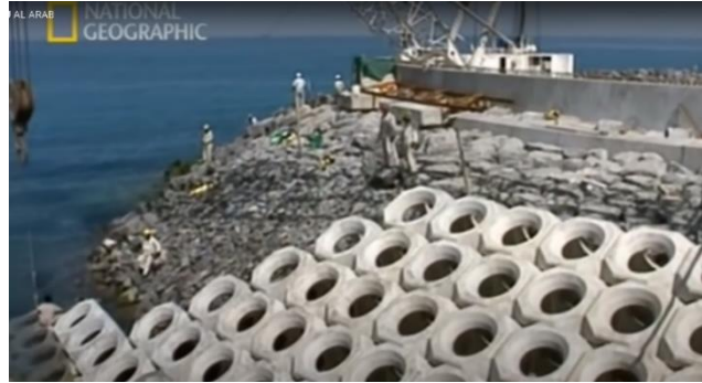
Figura 6. Forma de colocación del bloque de concreto en defensa de los taludes de la base del hotel Burj al Arab (Fuente: National Geographic, 2016).
