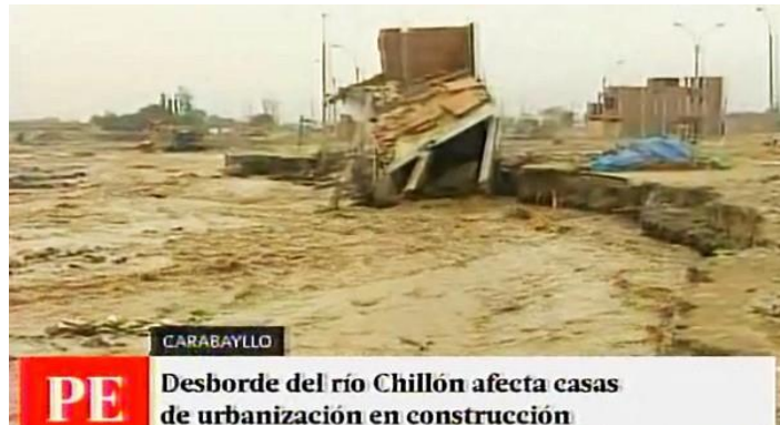
Figura 2. Colapso de vivienda de 2 pisos de material noble y 12 lotes afectados (Fuente: américas noticias,2017).
