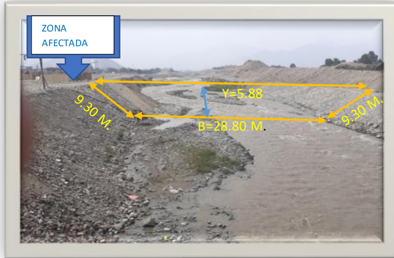
Figura 18. Levantamiento de medidas en campo.
