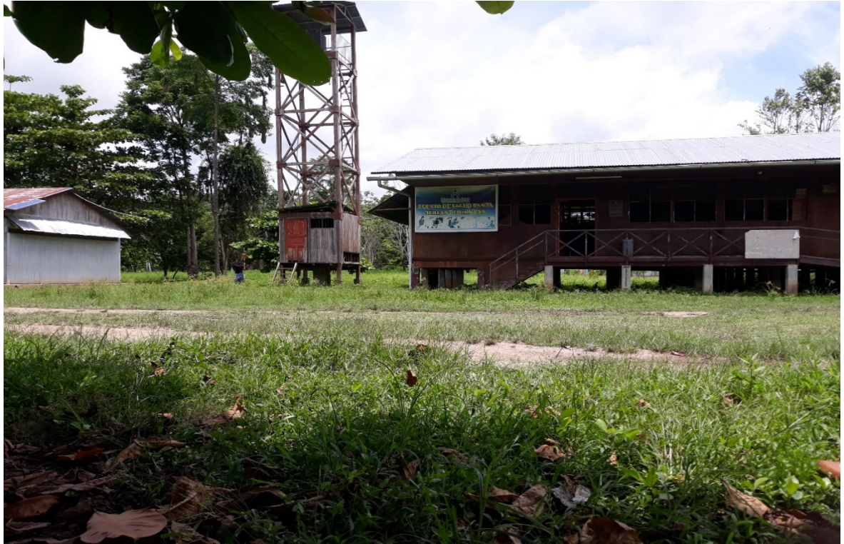
Foto 01: Sistema existente de Abastecimiento de Agua – No Operativo
