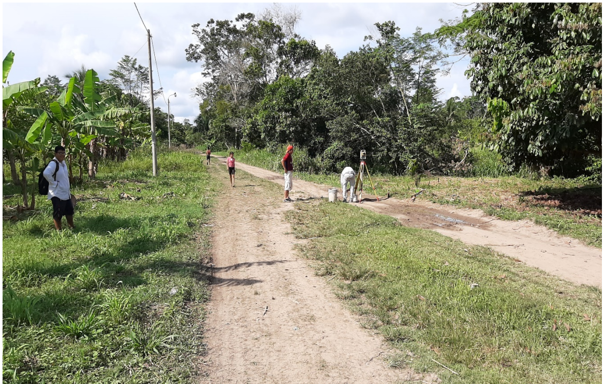
Foto 04: Colocación de Hitos Georreferenciados
