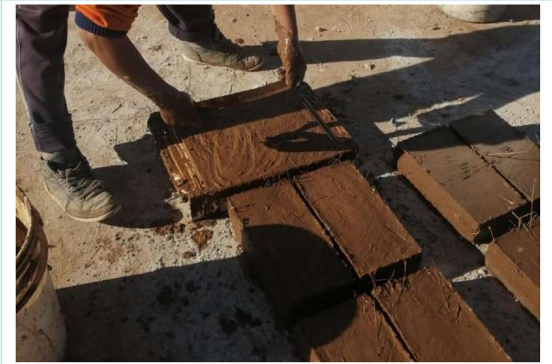
**FOTO N° 9:** Enrazado de la mezcla en el molde
