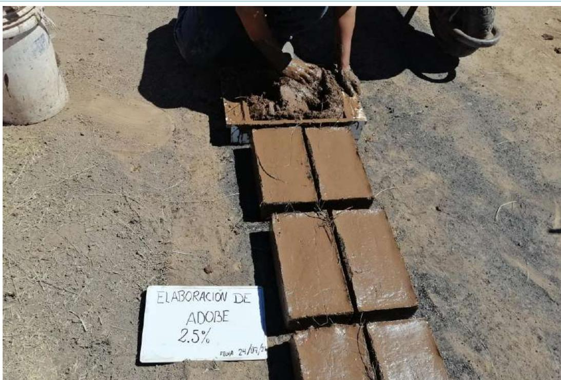
**FOTO N°6:** Adición de fibra de las cenizas de hornos ladrilleros
