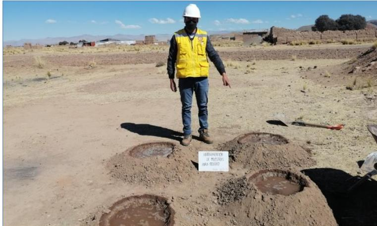
*Figura 9: Homogenización de la pasta de tierra*
