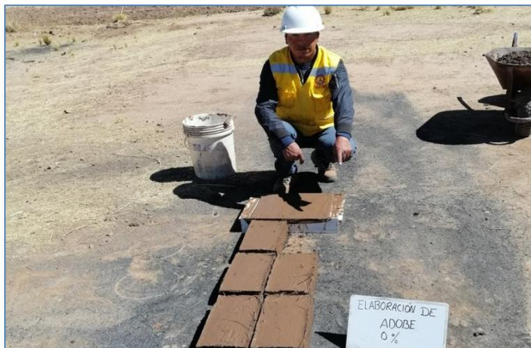
*Figura 10: Moldeado y desmoldado*
