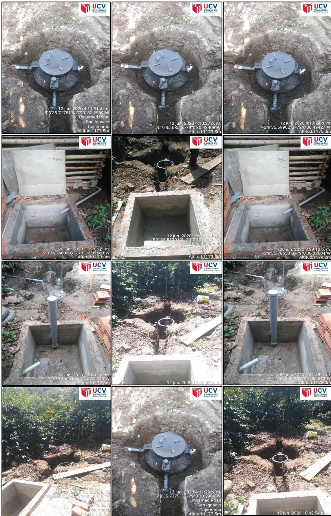
Figura 11. Unión de los percoladores con el rotoplas
