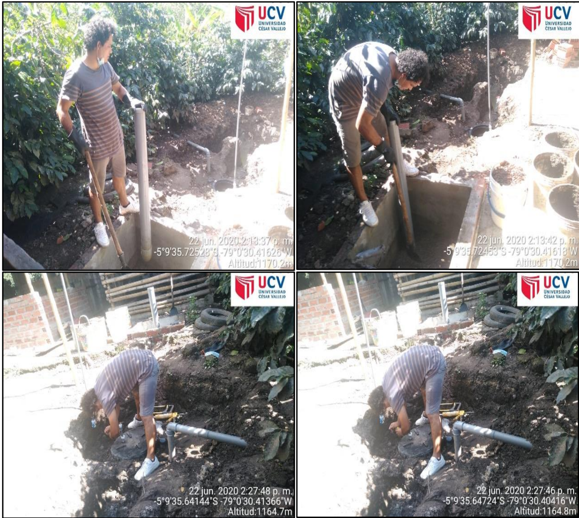
Figura 16. Sellado del biodigestor y el percolador
