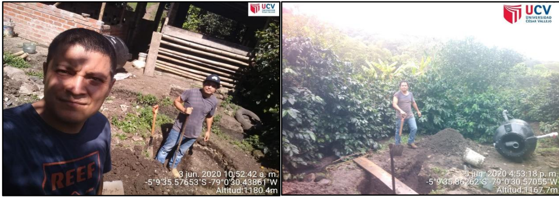
Figura 7. Excavación de hueco para el rotoplas
