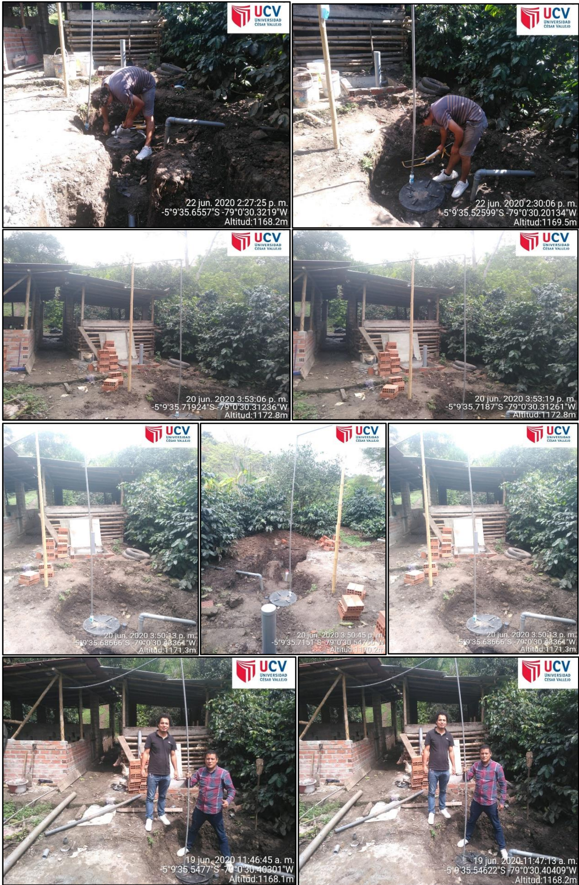
Figura 12. Tapado y sellado del rotoplas y las tuberías
