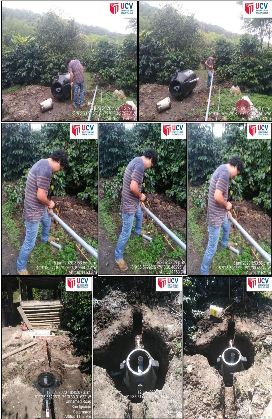
Figura 10. Instalación de tuberías y llaves de paso de PVC
