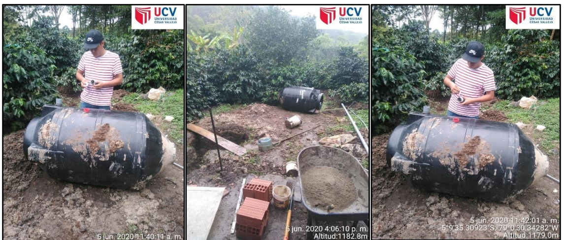
Figura 9. Instalación del rotoplas
