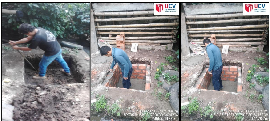
Figura 8. Construcción de los percoladores
