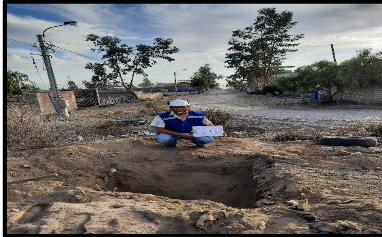
Realización de la Calicata 02 del centro poblado señor de los milagros.
