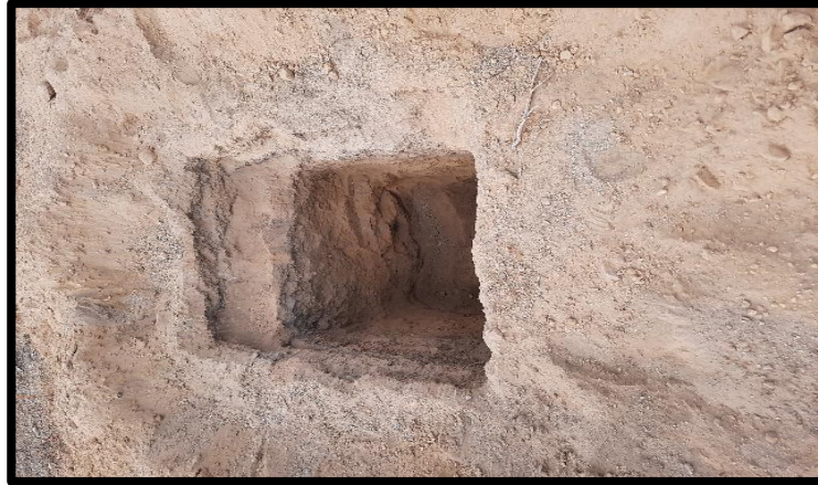
Profundidad realizada de la calicata C3 de 1.50cm.
