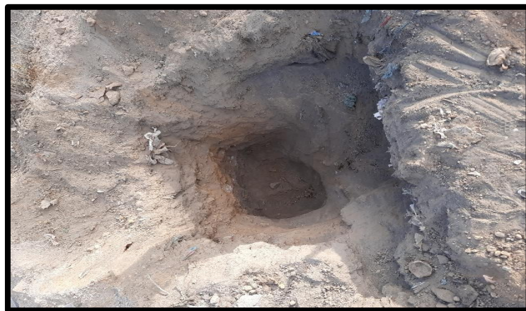
Profundidad realizada de la calicata C2 de 1.50cm.
