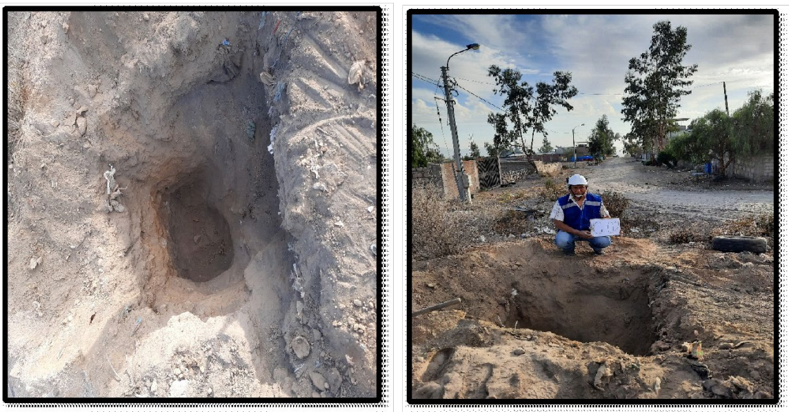
Figura 8. Calicata 0.2 excavación a una profundidad de 1.50m.
