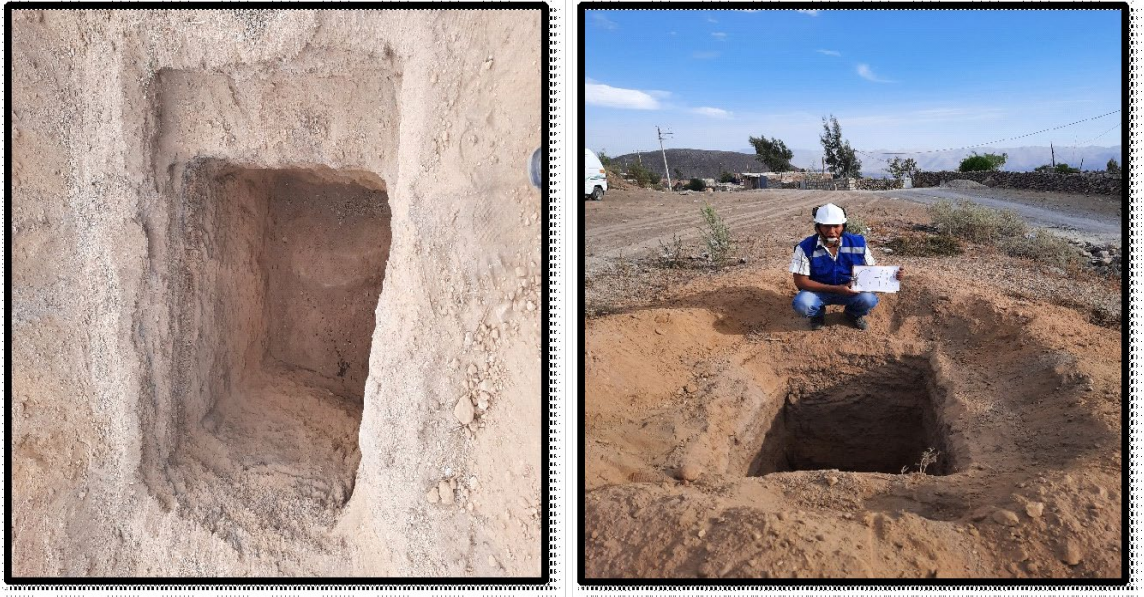
Figura 7. Calicata 0.1 excavación a una profundidad de 1.50m.
