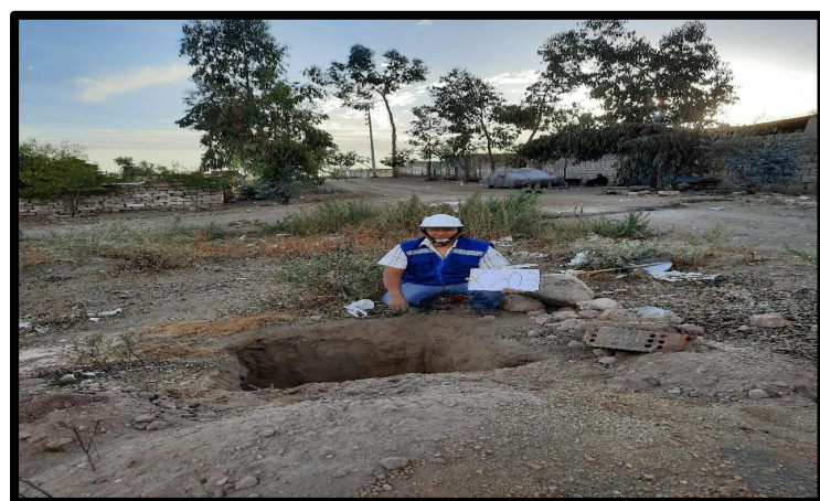
Realización de la Calicata 03 del centro poblado señor de los milagros.
