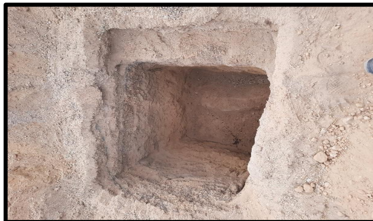
Profundidad realizada de la calicata C1 de 1.50cm.
