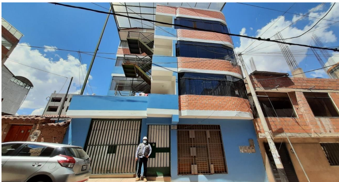
Figura 1.2. Edificio multifamiliar Romero Vera.
