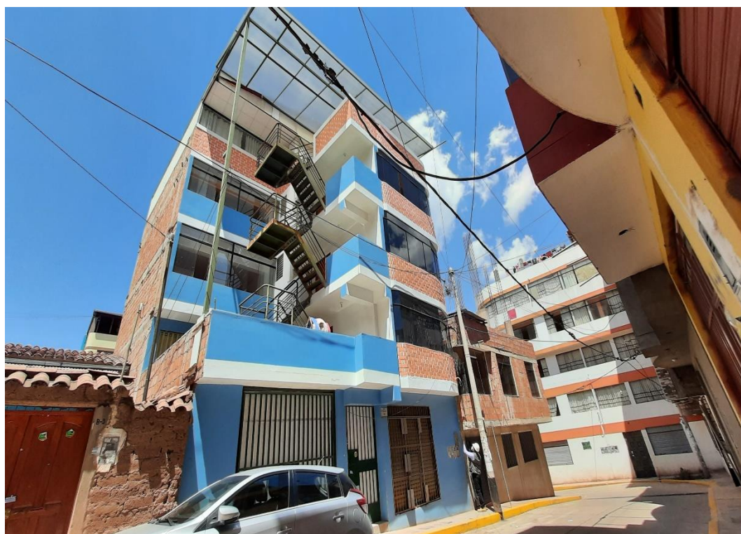
Foto 2: Vista exterior, alturas discontinuas con la edificación adyacente.
