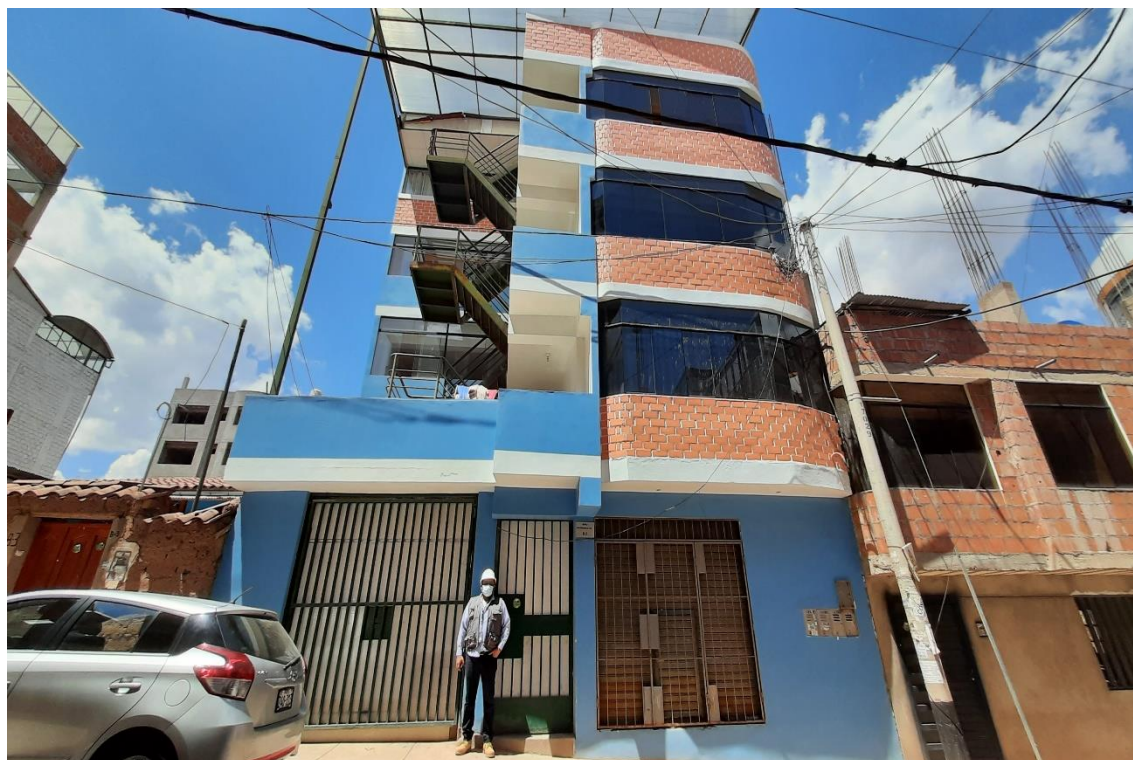
Foto 1: Vista actual de fachada principal de la edificación.
