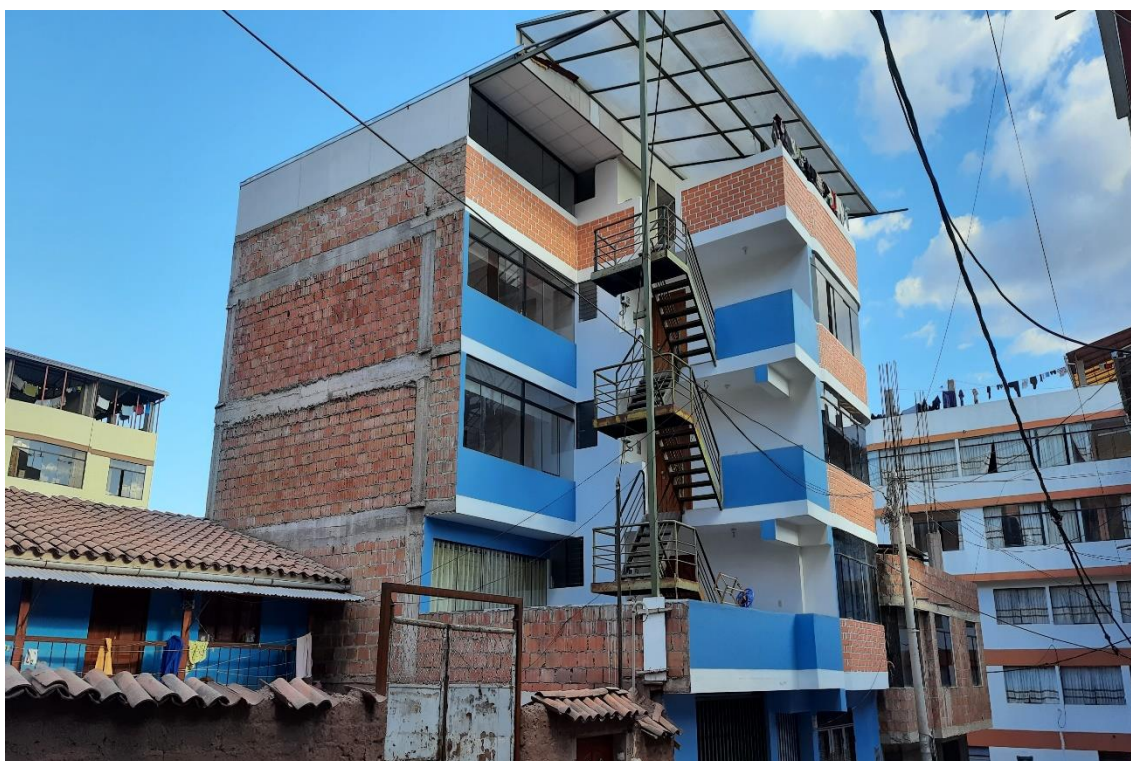
Foto 6: Vista exterior, edificación evaluada.
