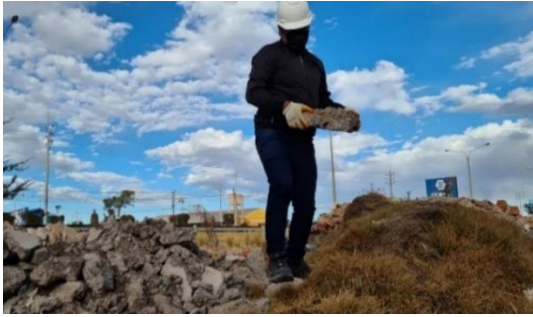
Foto 01: Recolección de escombros de concreto
