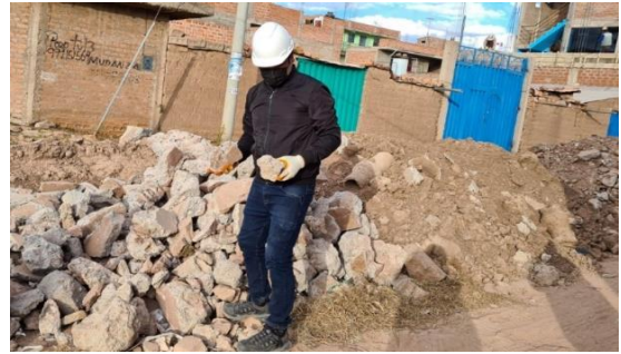
Foto 02: Recolección de escombros de concreto
