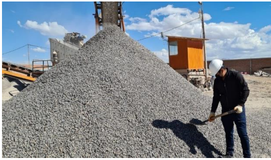
Foto 09: Suministro de agregado grueso
