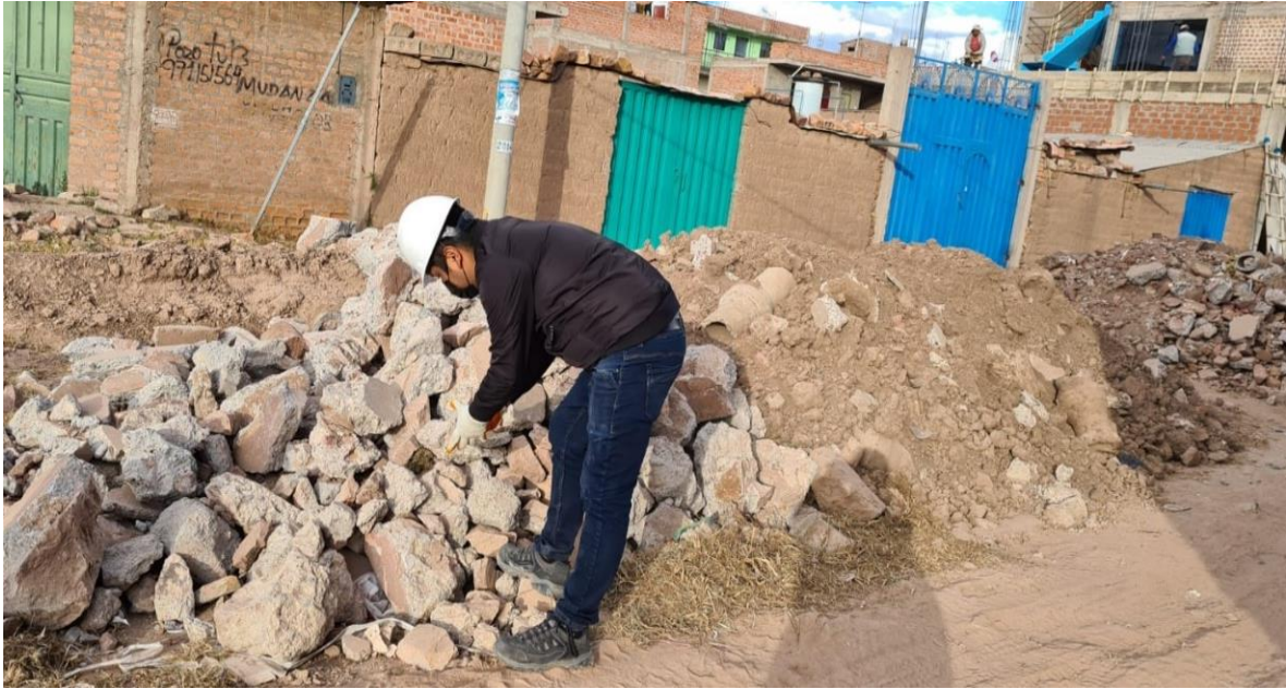
Figura N° 5: Residuos de construcciones en general.
