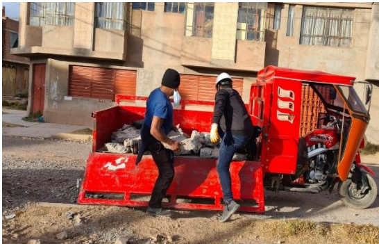
Foto 03: Carguío y transporte de escombros de concreto
