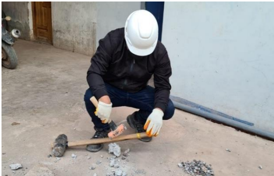
Foto 05: Trituración manual de concreto
