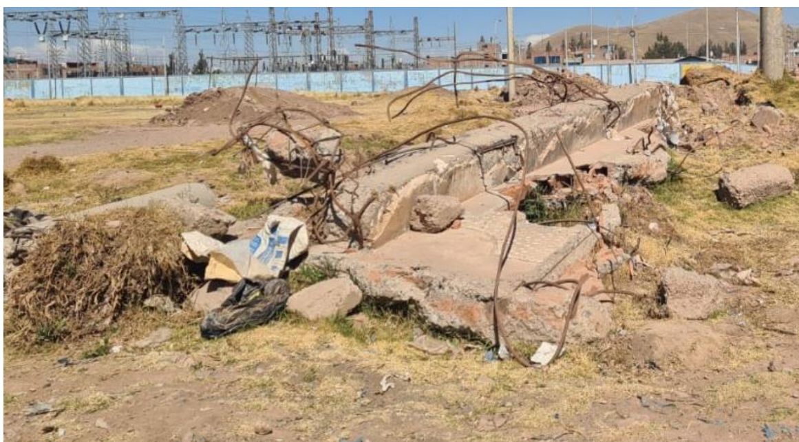
Figura N° 4: Escombros de demolición de una vivienda de concreto armado. Fuente: Elaboración propia.
