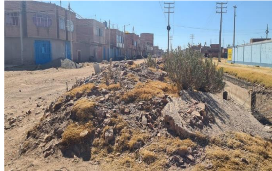
Foto 04: Recolección de escombros de concreto
