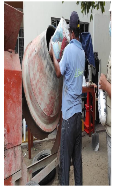
Preparación de mezcla de concreto
