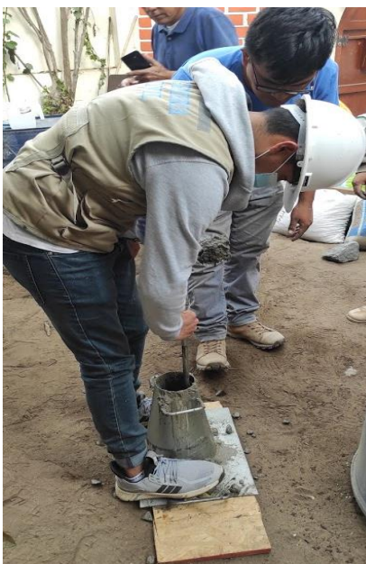
Chuseado de concreto para prueba slump
