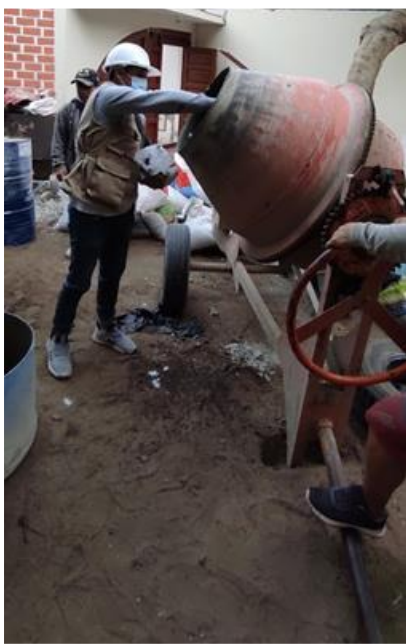
Adicionando fibras de polipropileno
