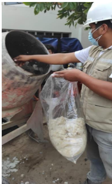
Adicionando fibras de lana de oveja
