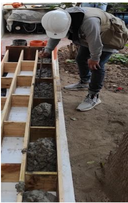
vaciado de concreto en las probetas
