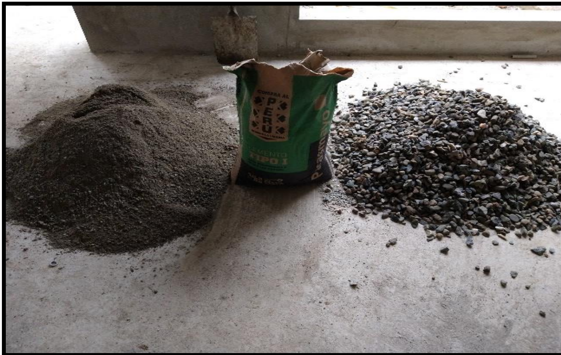
Fotografía 8. En esta foto se observa las muestras de los agregados y cemento a utilizar.
