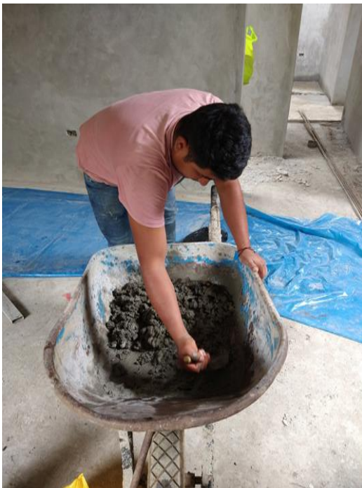
Fotografía 15. En esta foto se observa la preparación del concreto con adición de aserrín de madera y CCA.
