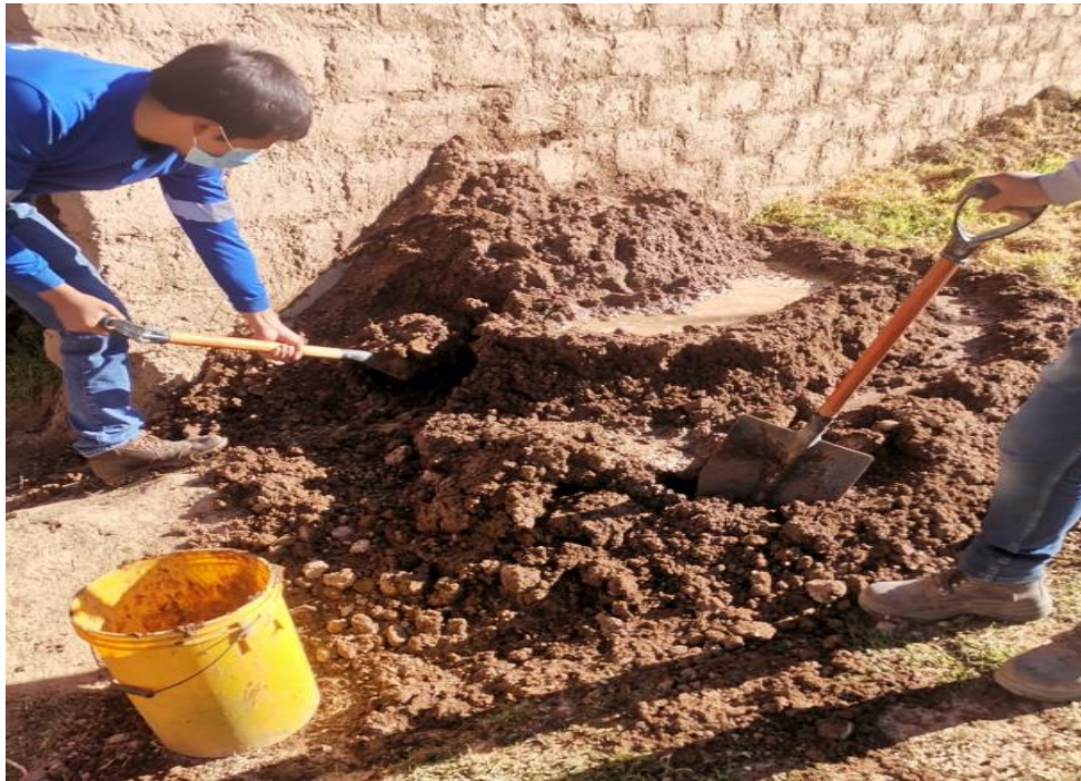
Fotografía 8. Humedecimiento de tierra. Fuente: Elaboración propia
