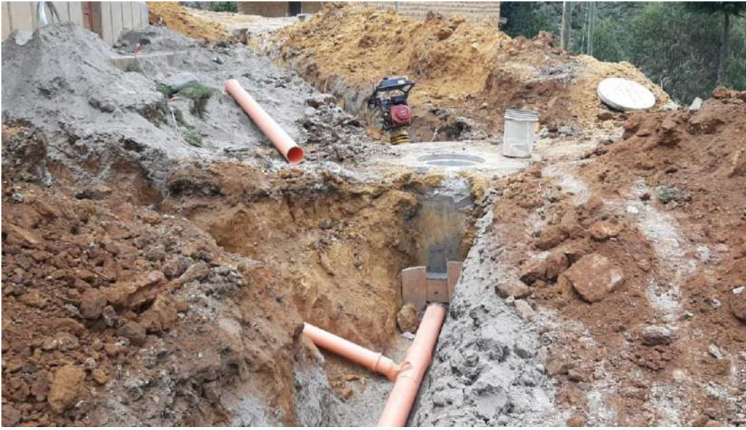
Figura 17: Vista de los dados de concreto para empalme de buzón con tubería PVC UF DN 160 MM Y 200 MM. También se observa las conexiones domiciliarias de alcantarillado.
