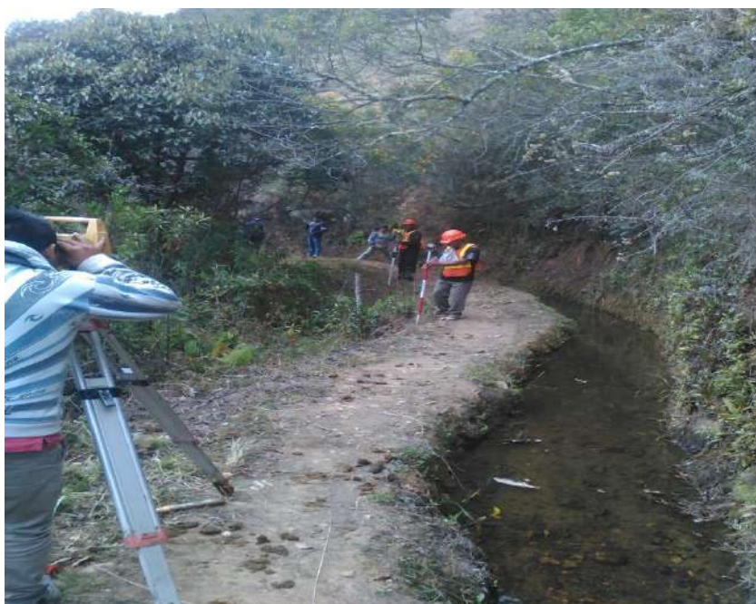
FIGURA 04: LEVANTAMIENTO DE LINEA DE CONDUCCION
