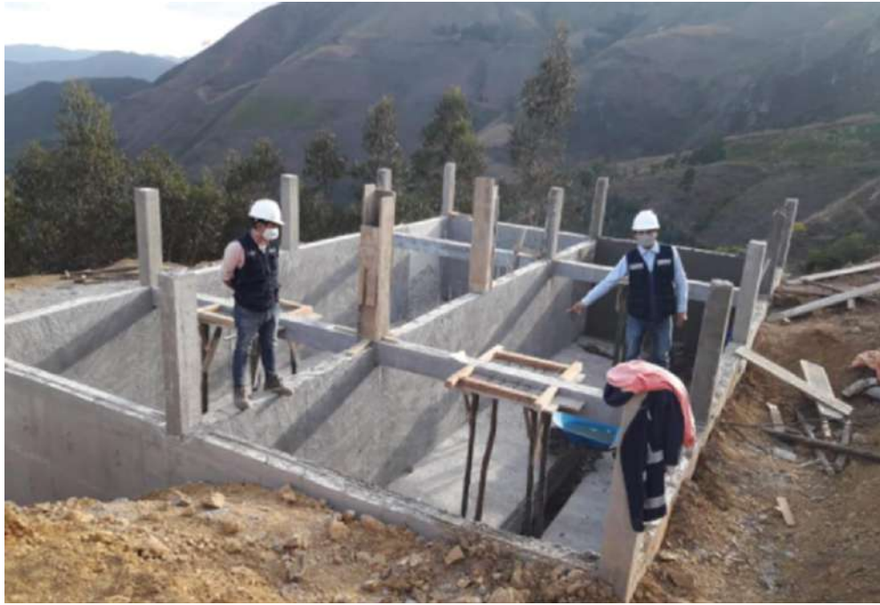
Figura 21: En las imágenes se puede apreciar los trabajos de tarrajeo en el Lecho de Secado de la PTAR.
