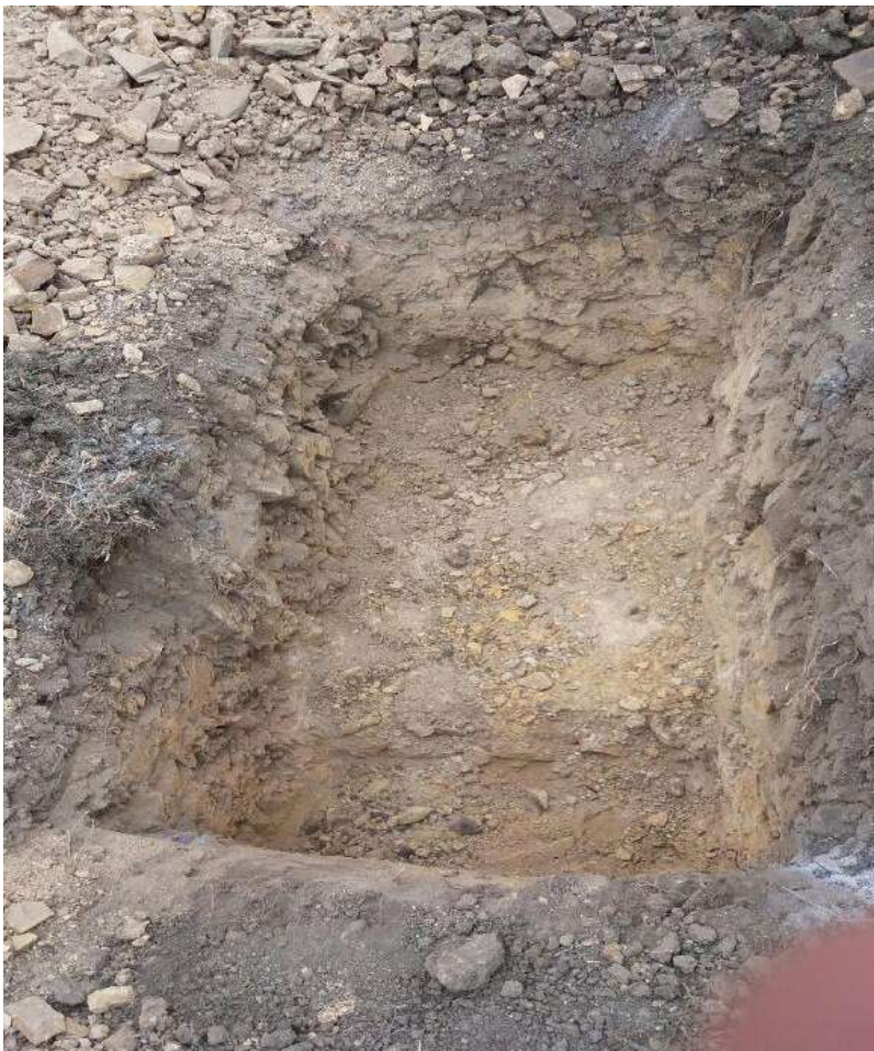
TRAZADO Y EXCAVACION DE CALICATA N°8
