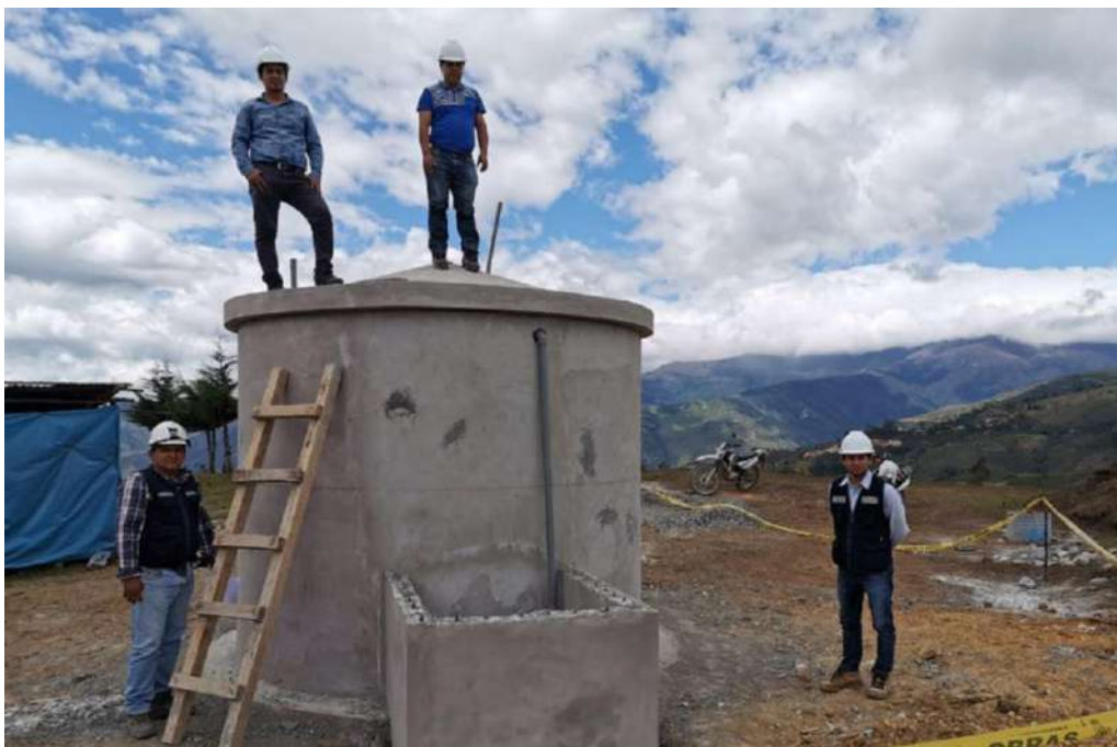
Figura 8: Vista del revestimiento exterior del Reservorio de 12 m 3 .
