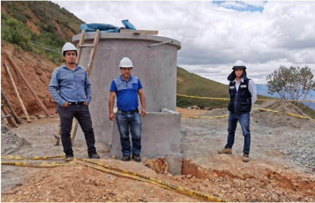
Figura 7: Vista del revestimiento exterior del Reservorio de 5 m 3 .
