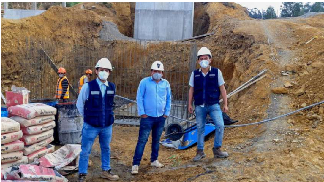
Figura 22: Vista armado de acero del Filtro Biológico en la PTAR.
