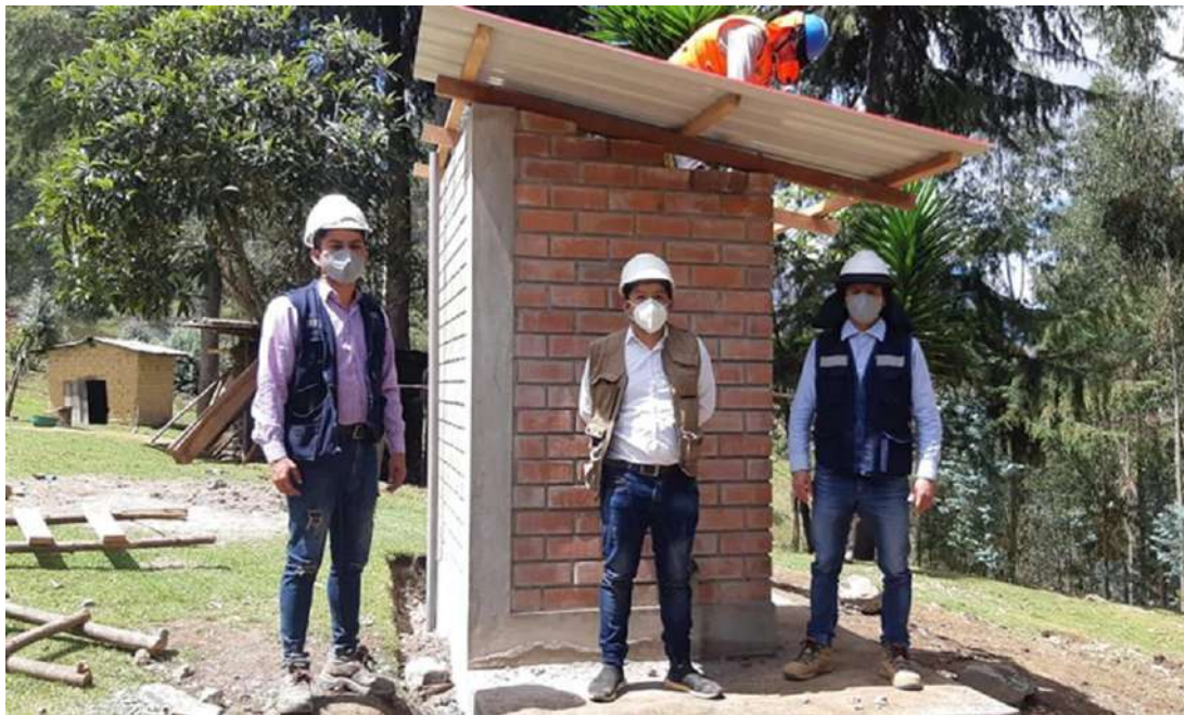
Figura 24: En las imágenes se puede apreciar la instalación de la Cobertura con Plancha de Aluzinc en las Unidades Básicas de Saneamiento (UBS).
