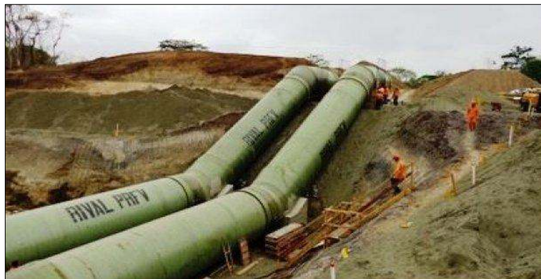
Figura 5. Fotografía de un sifón invertido
