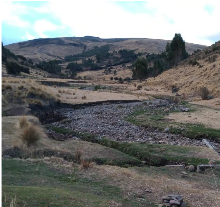
Figura 15. Punto de captación del agua (bocatoma)
