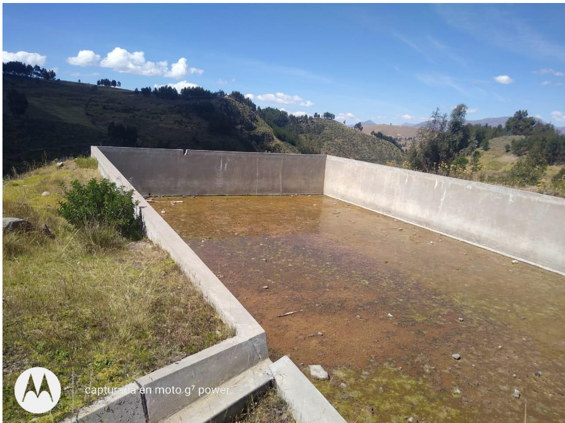
Figura 58. Reservorio principal fuente de abastecimiento del riego tecnificado
