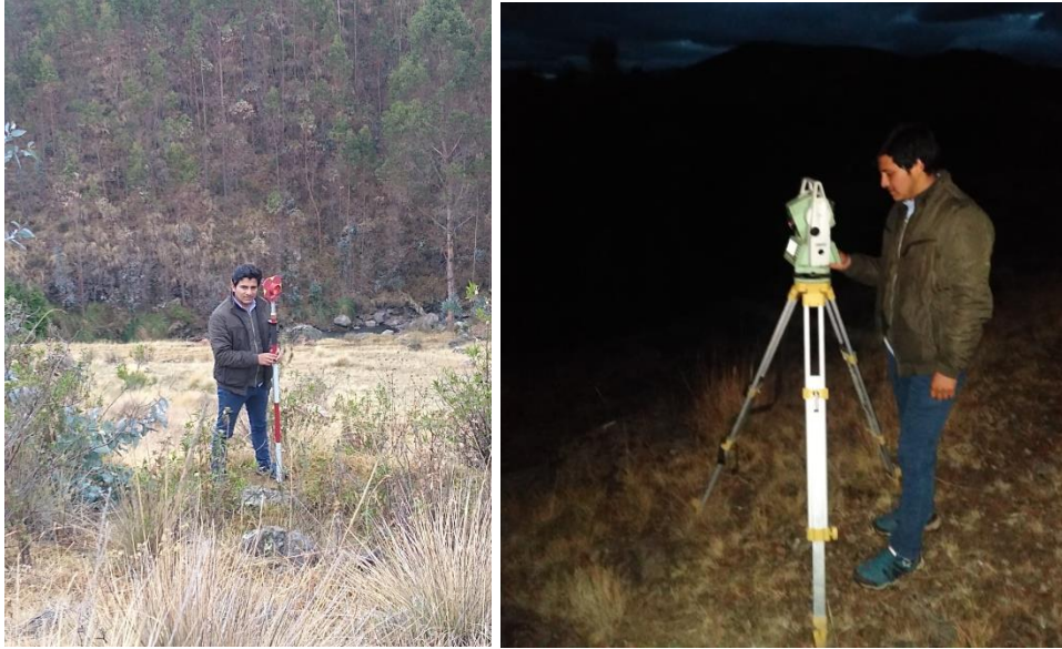
Figura 16 y Figura 17. Trayecto del levantamiento topográfico desde la bocatoma hasta el reservorio.
