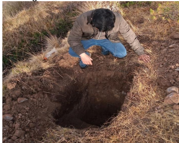
Figura 19. Calicata terminada
