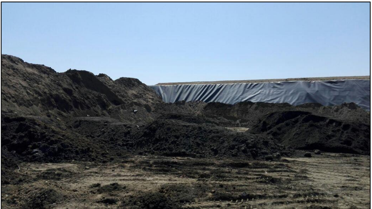
Trinchera sin confinar - Suelo Contaminado con Hidrocarburos proveniente de Refinería Talara
