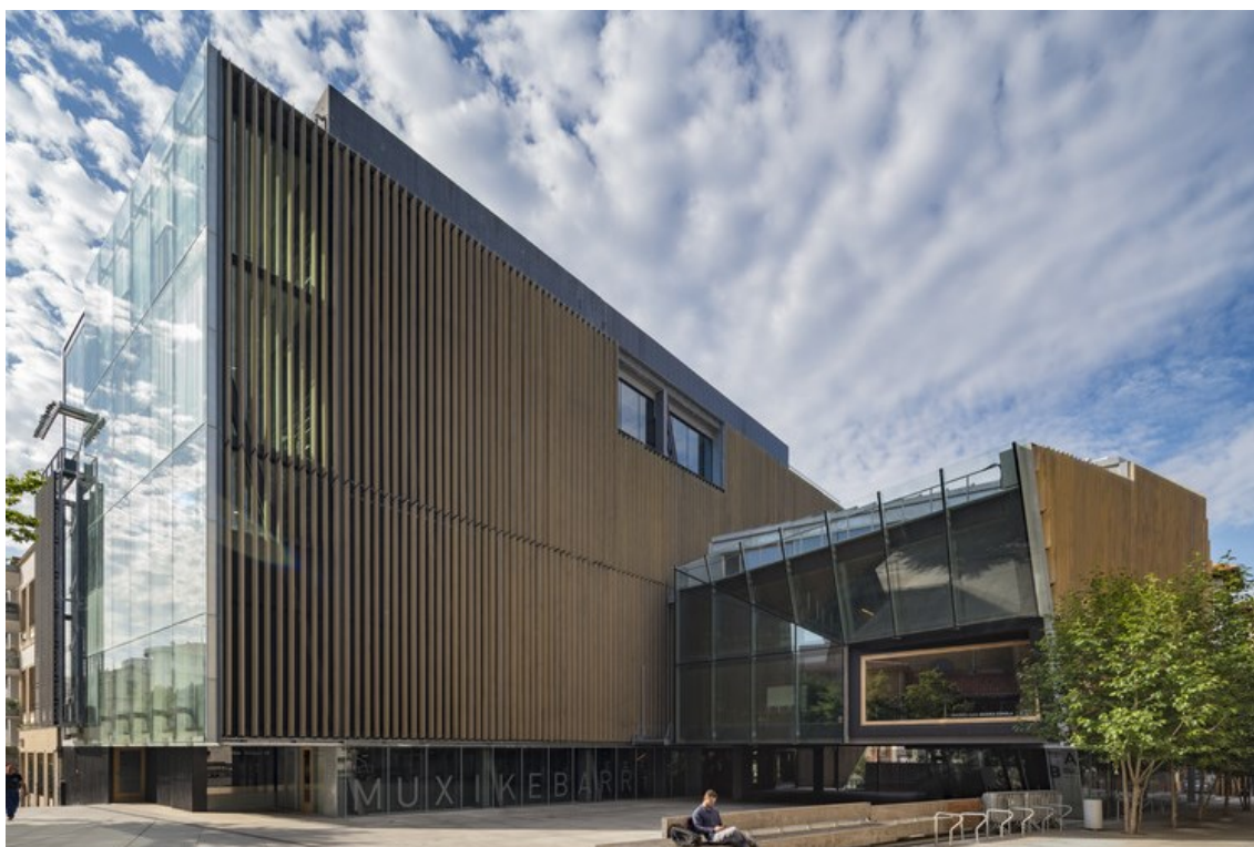
Figura 1. Centro de Artes Escénicas. Fuente: https://www.archdaily.pe
