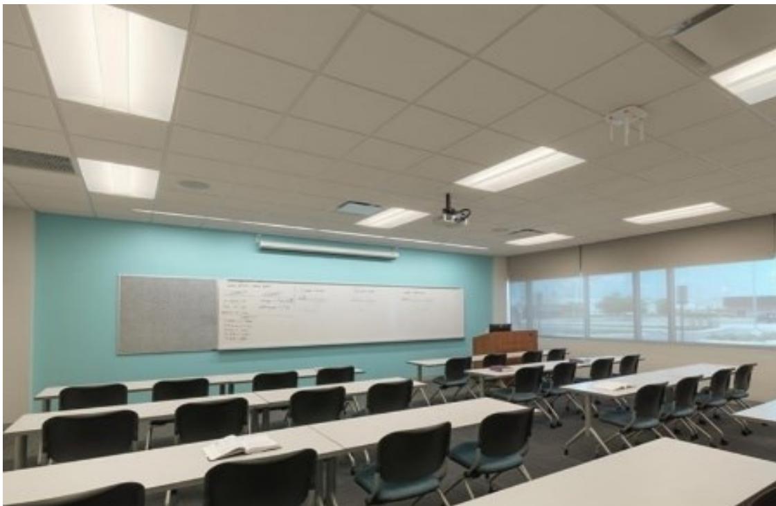
Figura 17. Luminarias por aprovechamiento de la luz. Recuperado de IDAE (2005)
