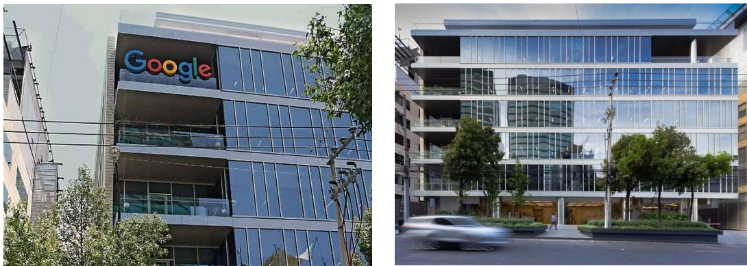
Figura 8: Vista de fachada Google / Fuente: Mypress
