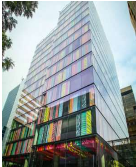
Figura 17: Torre Wework centro empresarial Real Fuente: Wework
