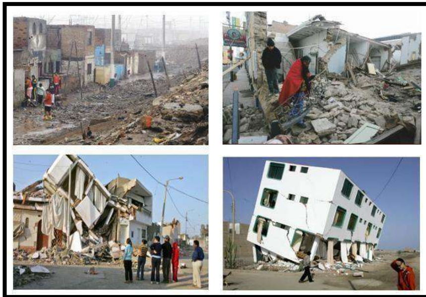
Figura N°4 Daños causados por el terremoto del 2007-Perú. Fuente: http://www.nacion.com/ln_ee/2007/agosto/16/ultima-sr1206498.html
