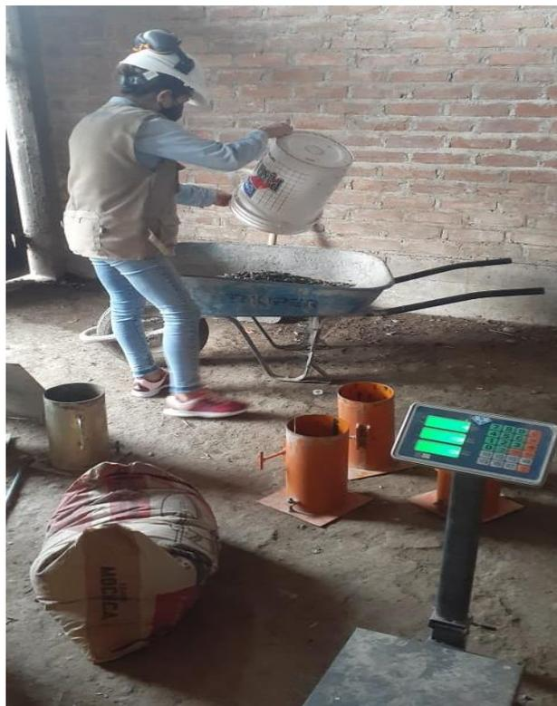
Figura 10. Mezcla de los materiales para la preparación del concreto.
