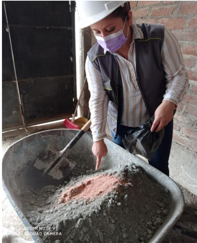
Figura 10. Agregando componente rico en aluminio activado en la mezcla de concreto
