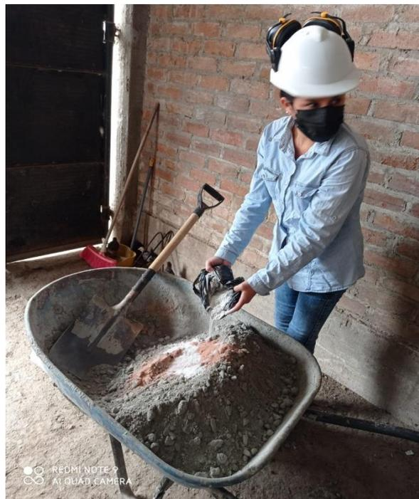
Figura 12. Agregando el componente rico en silicio activado a la mezcla de concreto.
