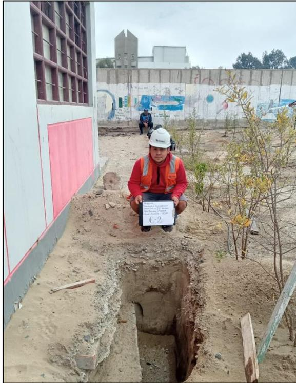
**Figura 05: Excavación de calicata
