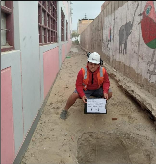
**Figura 04: Excavación de calicata
