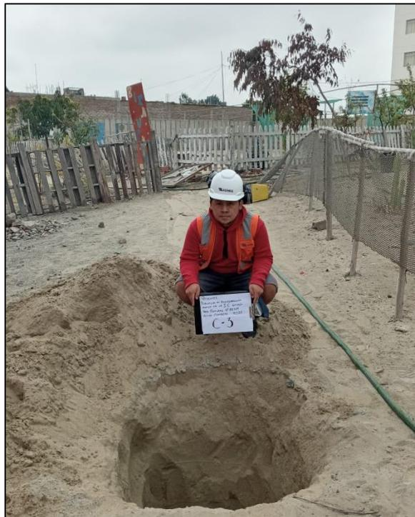
**Figura 06: Excavación de calicata
