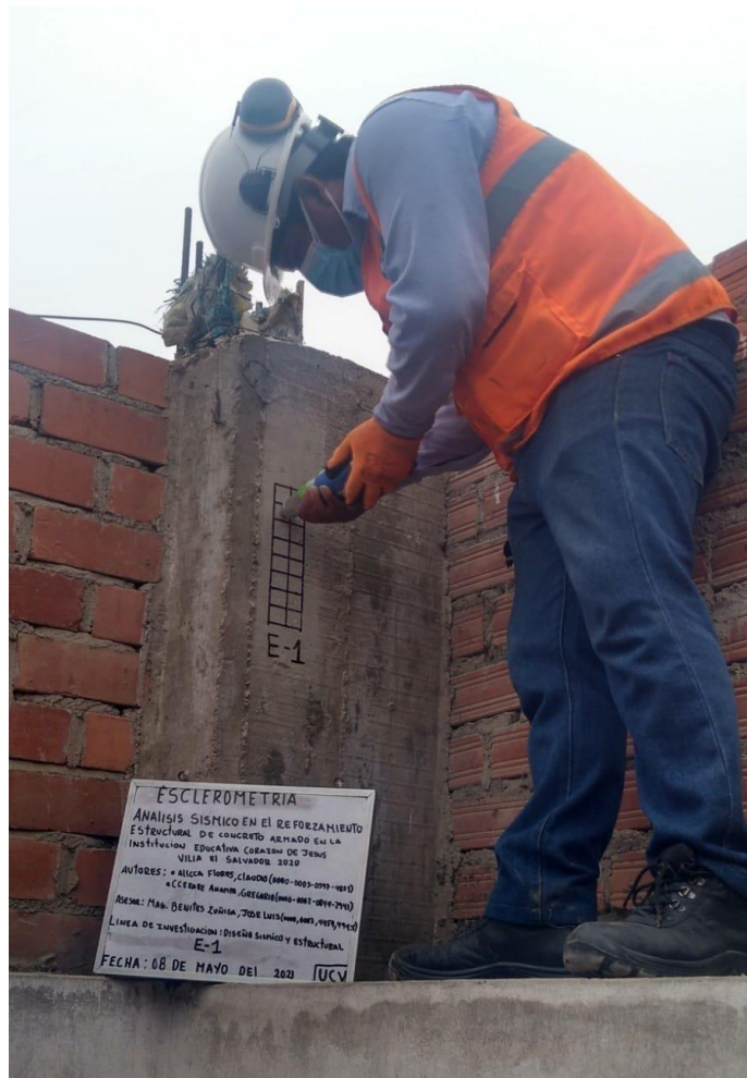
Figura 6. Ensayo de esclerometría.
