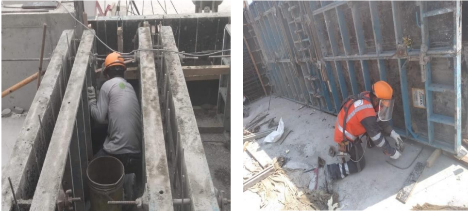
Figura 1: Exposición de los operarios carpinteros en el peligro de posturas forzadas
