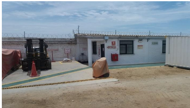
Figura 13: Almacén General Fuente: Elaboración propia
