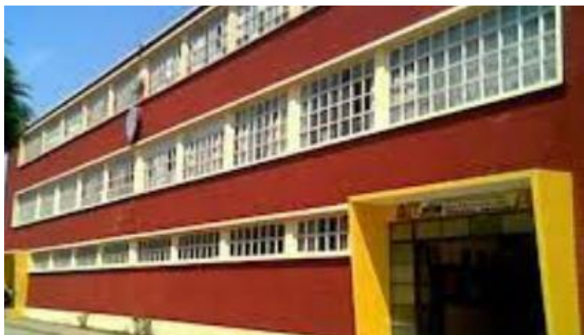
Figura N° 53: Colegio San Luis Gonzaga
