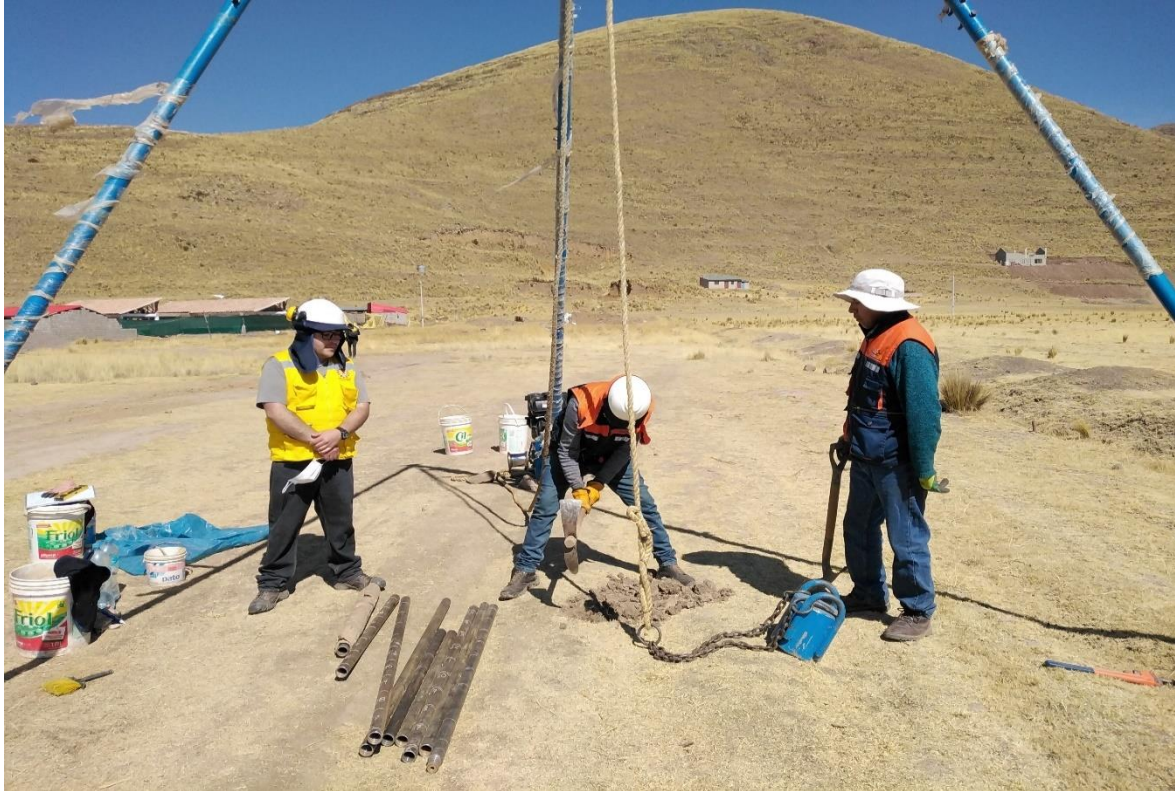
Preparación de Punto para Sondaje SPT
