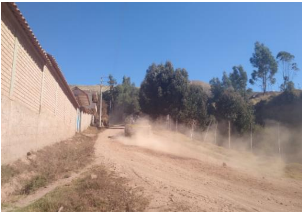
Figura 1. Carretera a nivel de subrasante Huilcarpay (Problema de Exceso de Polvo) en épocas de sequía
