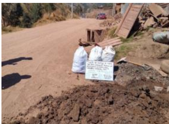
Figura 15. Extracción del Suelo Calicata 01
