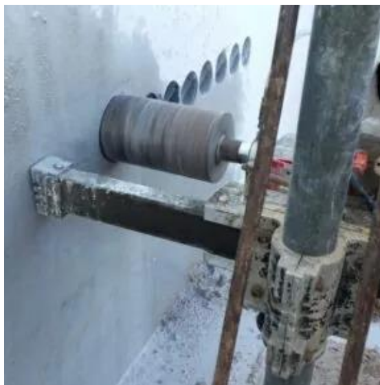
Figura 4. Obtención de núcleos horizontales
