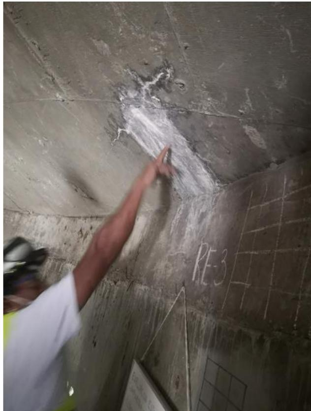
*Figura 6.* Presencia de eflorescencia en el fondo cónico del Reservorio Elevado R-3 “Sánchez Cerro” – Sullana – Piura.
