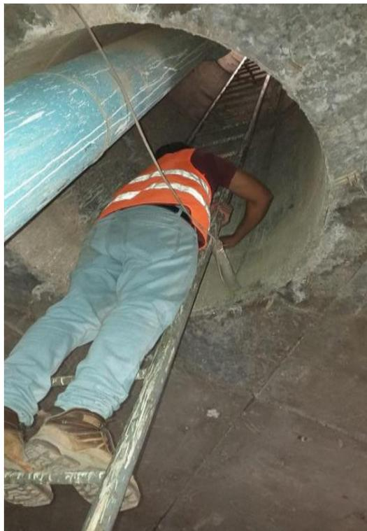
Fotografía 2. Realización de ensayos no destructivos de esclerometría en la chimenea del reservorio elevado R-3 “Sánchez Cerro” de la provincia de Sullana.
