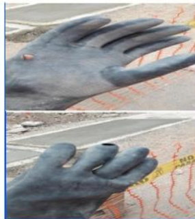
Uso de guantes de jebe en mal estado (con agujeros)
