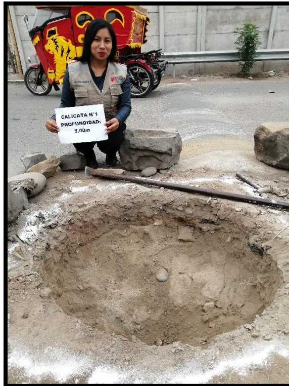
Figura 82. Ubicación de la Calicata-1
