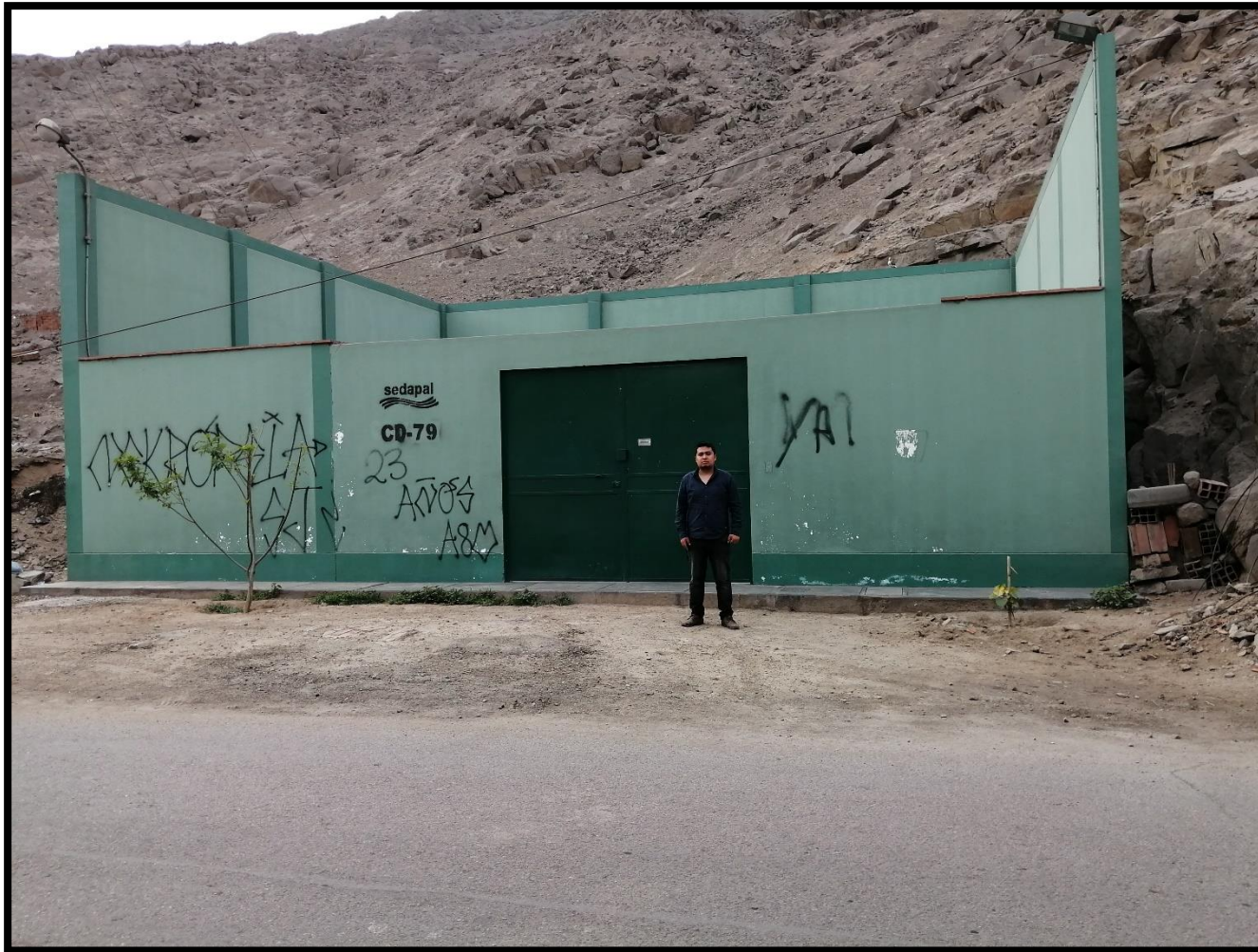
Figura 30. Cámara de Bombeo CD-79
