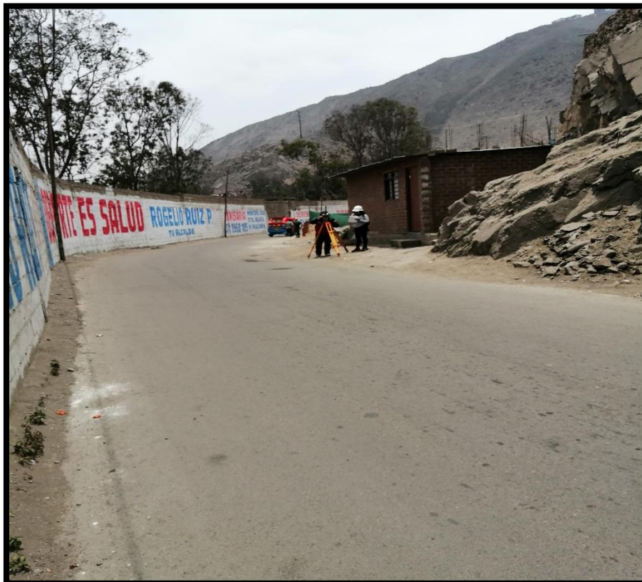
Figura 79. Levantamiento de pista, vereda E-5
