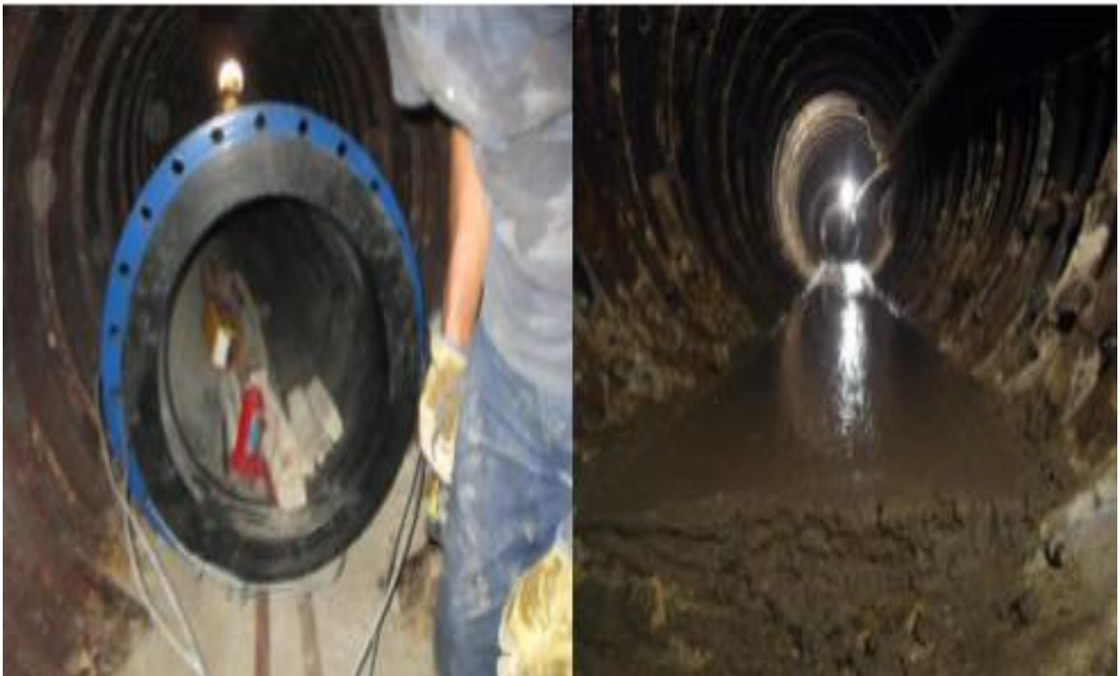
Figura 25. Instalación de la tubería en el túnel liner
