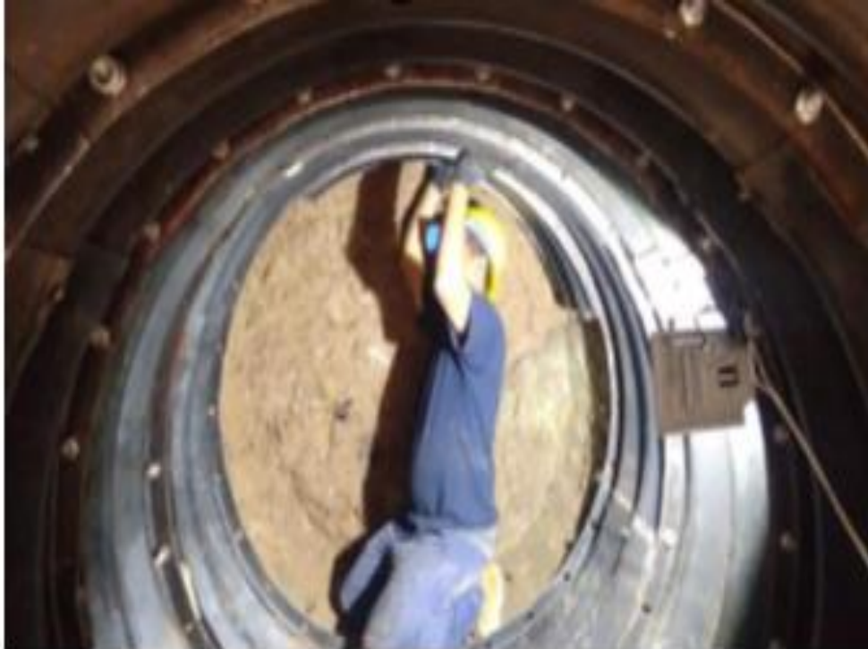
Figura 19. Armado del segundo anillo en horizontal Fuente: Tecnovial, 2012
