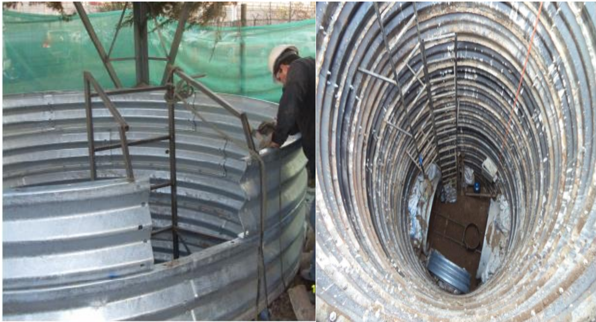
Figura 17. Procedimiento de armado en piques. Fuente: Tecno Vial, Carrasco, 2013
