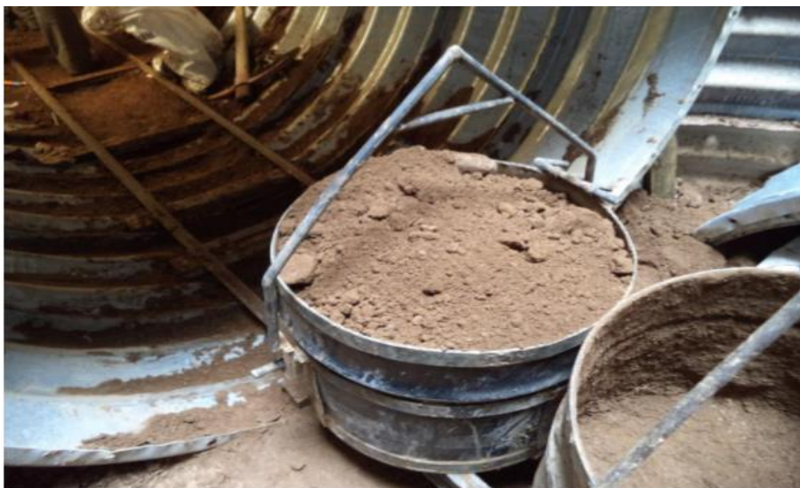
Figura 22. Proceso de armado y retiro de marina por medio de baldes desplazados sobre rieles Fuente: Carrasco, Trejo, tesis "túnel liner y su canalización en agua potable", 2013
