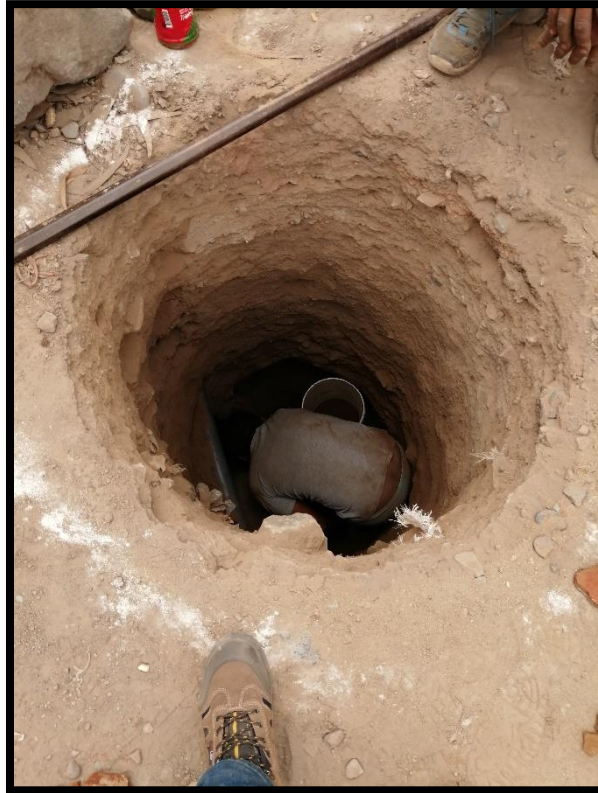
Figura 86. Proceso de excavación
