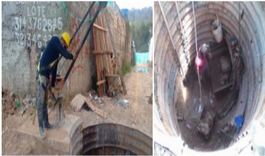
Figura 15. Armado de pique (pozo de inicio) Fuente, Tecnovial, 2002
