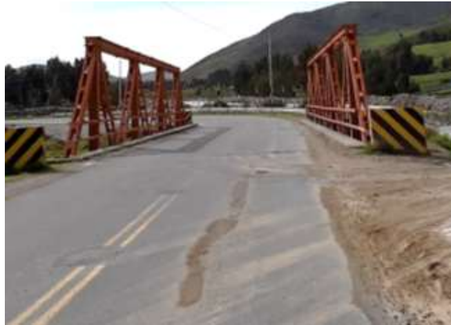
Figura 19. Ahuellamiento
