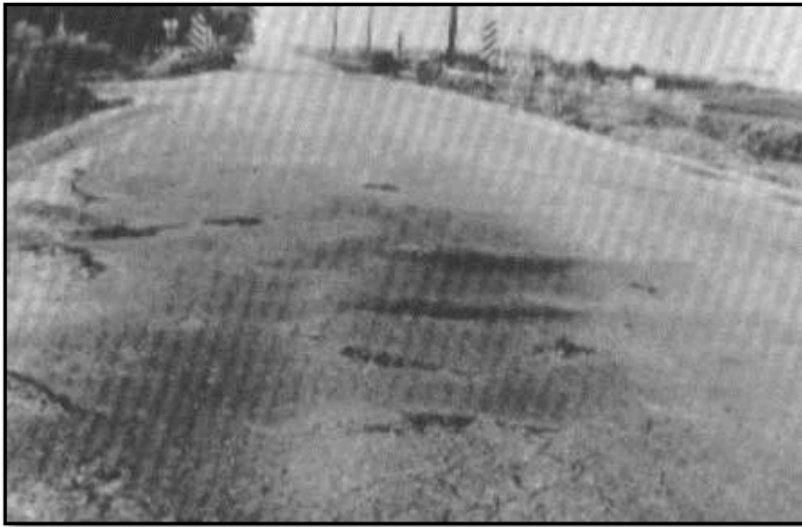
Figura 20. Desplazamiento
