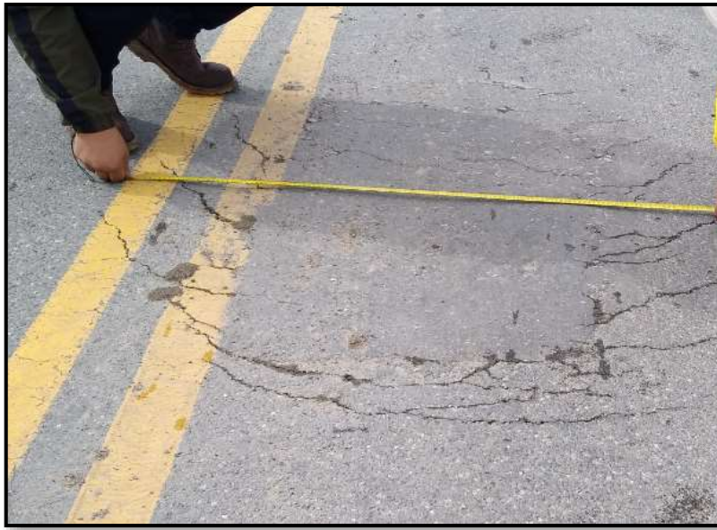
Figura 21. Grietas Parabólicas
