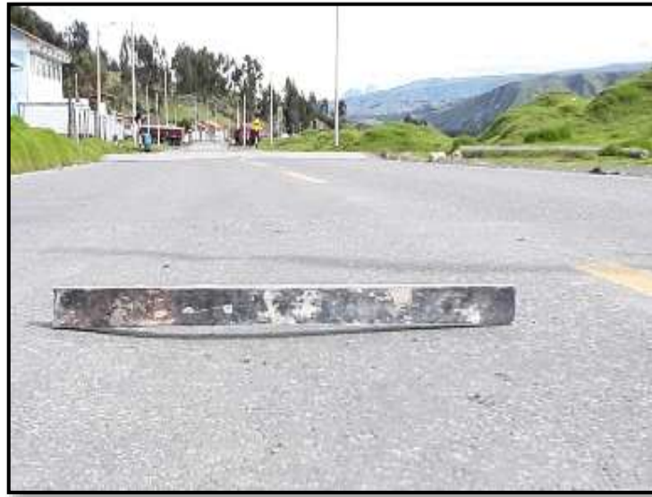
Figura 7. Hundimiento
