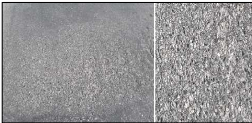
Figura 16. Pulimiento de Agregados
