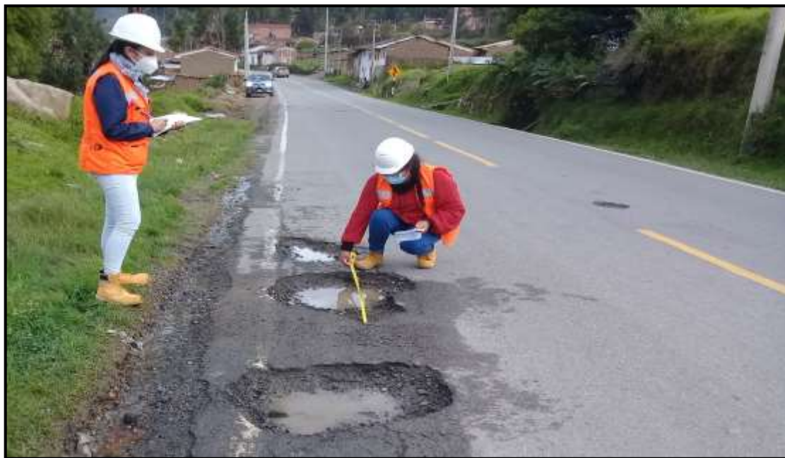
Figura 54. Mediciones y evaluación en falla de bacheo, fisura de borde y pulimiento de agregados
