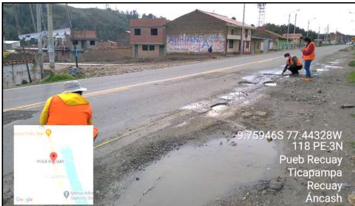
Figura 58. Evaluación y trabajos de medición en segundo punto crítico.
