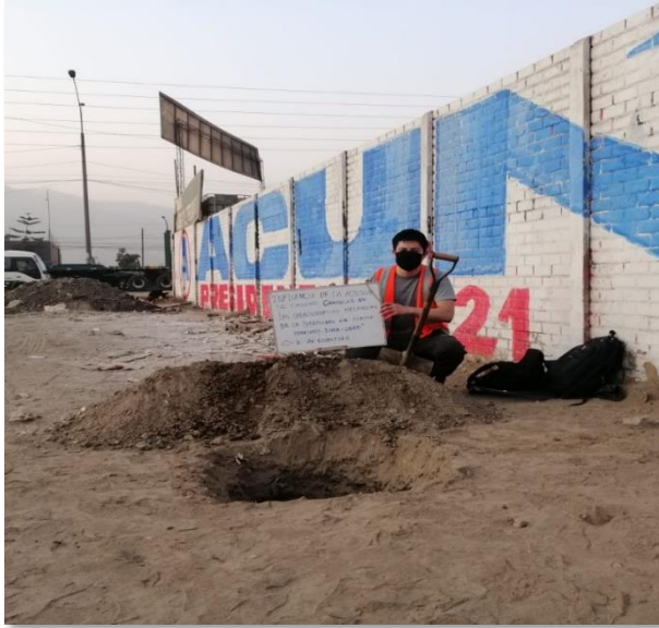
Figura: N° 30: extracción de calicata C-1
