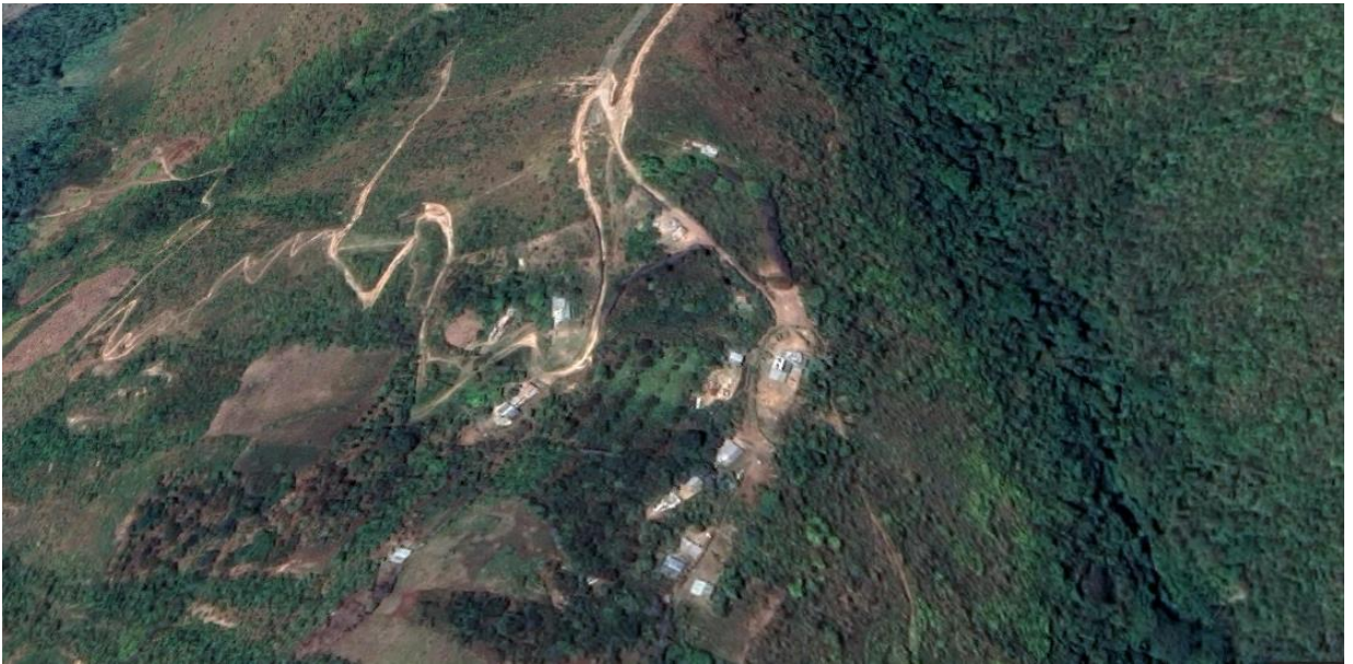
Foto 7. Sector el progreso
