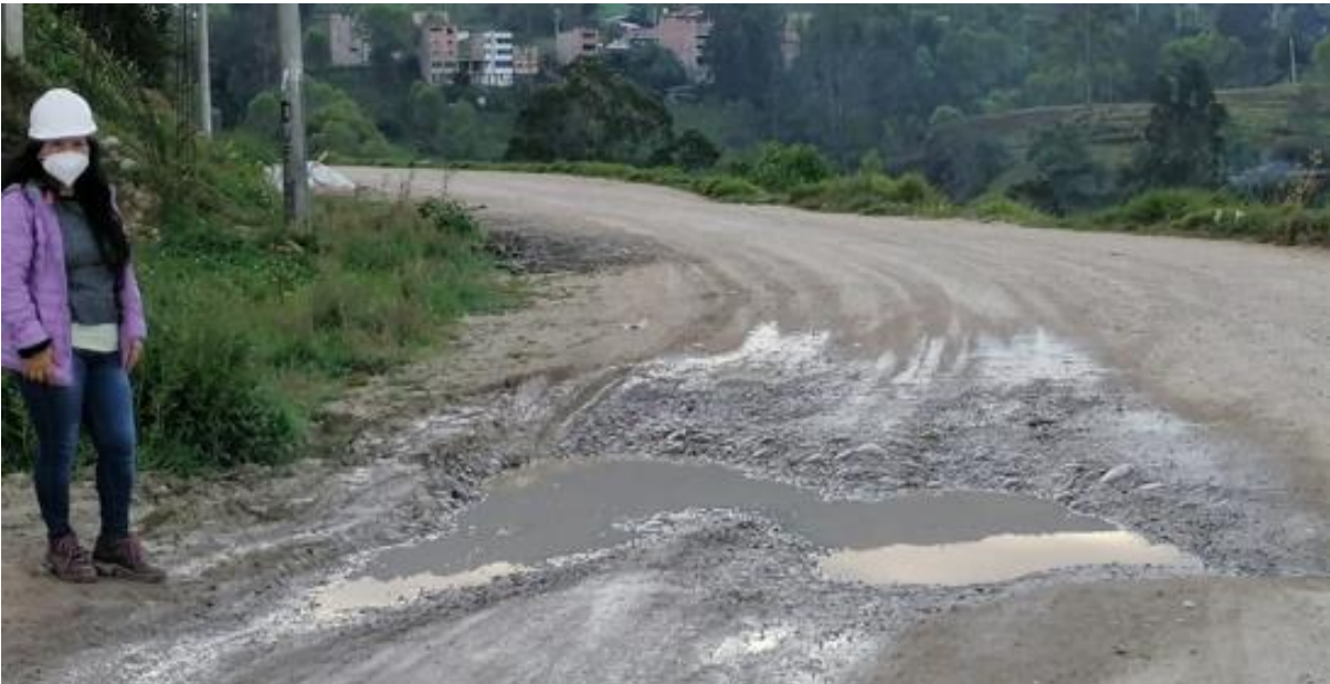
Mal estado de la vía.
