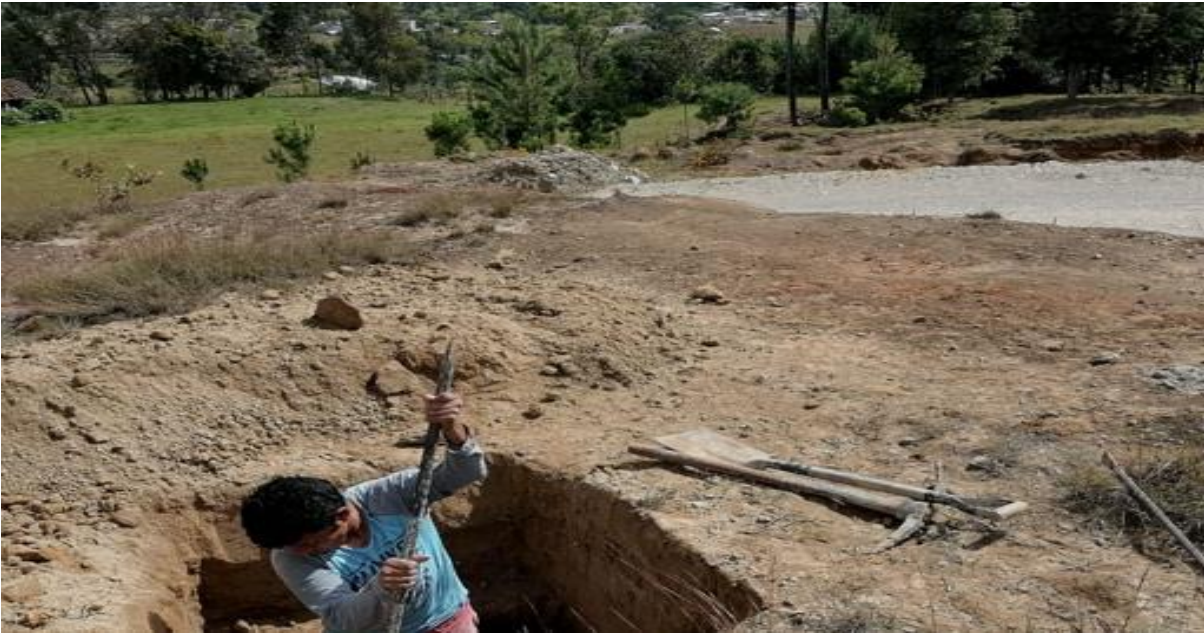
Calicata en el último tramo de la zona de estudio.
