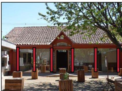
Posee un corredor con pilares de madera y posterior cierre de albañilería de ladrillo cerámico y cemento.
