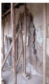
En esta cirugía se pueda apreciar dentro del sector este, el principal problema era con el muro con frente al patio interior. Se encontró parcialmente colapsado, debido ala apertura contemporánea de un vano de una puerta nueva que se apertura sin tener en cuenta las debidas condiciones de estabilidad estructural.
