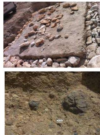
Por otra parte se pudo notar las variedad en la factura de los cimientos; algunos de ellos son de bloques de andesita y otros, de una mezcla de los anteriores con brechas volcánicas, composición no recomendable como material de cimentación por su bajo nivel de soporte antes esfuerzos de compresión y composición del material .
