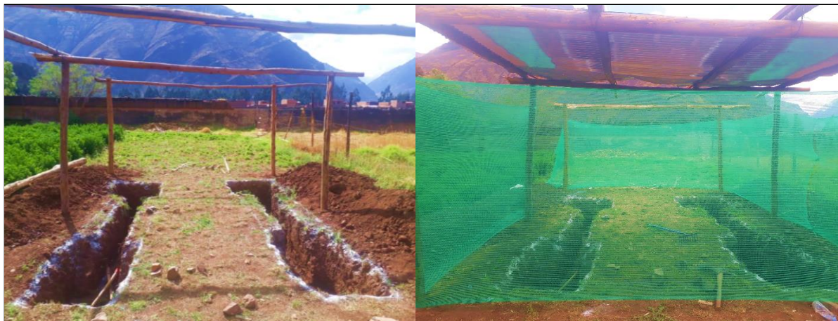
Figura 61. Zanjas terminadas para los HAFHSS y colocación de protección del espacio. Techo (palo de guayaquil y calamina) y malla raschel verde, se coloca este sistema de protección para evitar la lluvia y vientos de
