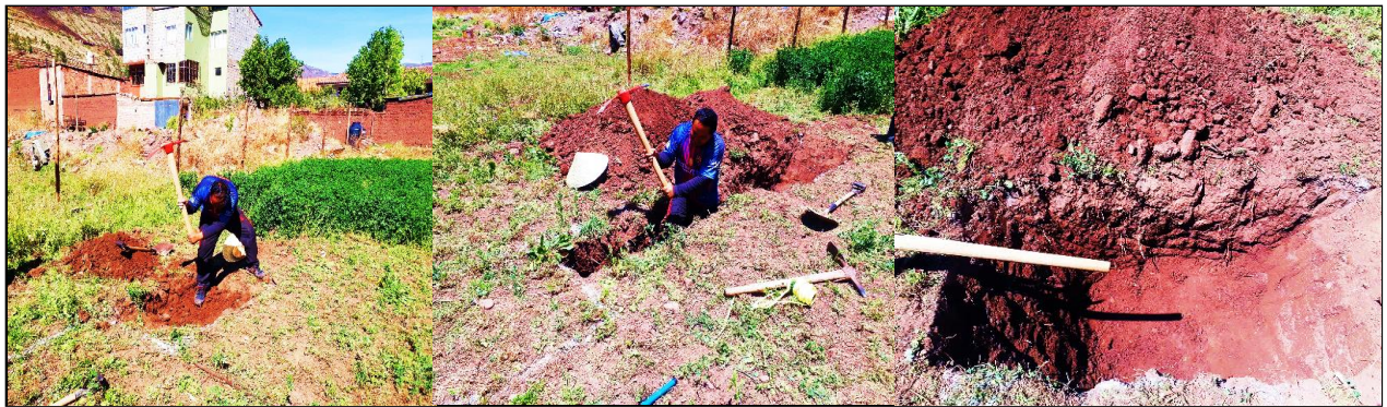
Figura 60. Picado y lampeado de tierra.
