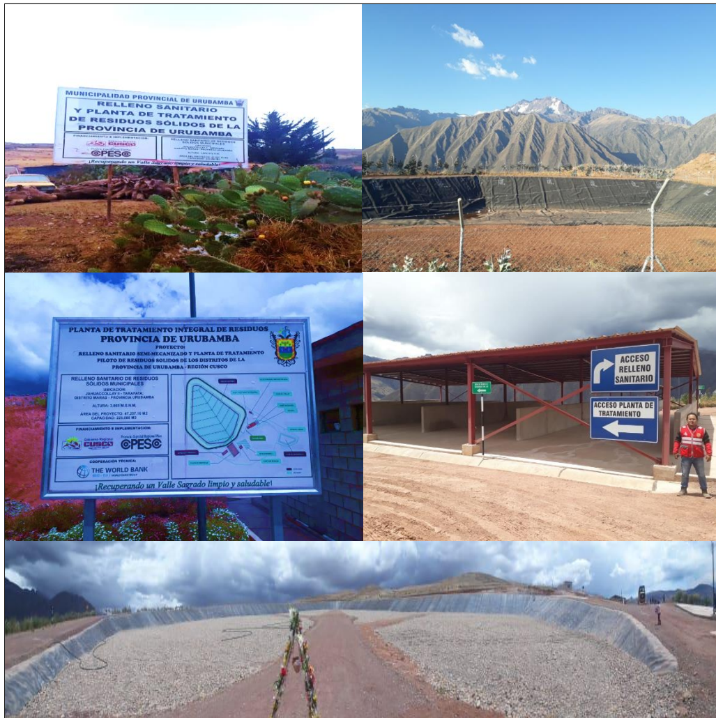
Figura 80. Relleno sanitario de la provincia de Urubamba. Para el 2020 inicia el funcionamiento del relleno sanitario semi-mecanizado y planta de tratamiento piloto de los residuos sólidos, con una capacidad de recepción de hasta 25 toneladas diarias y un horizonte de operación que se calcula entre 12 a 15 años.
