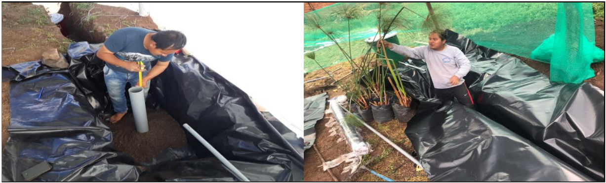
Figura 68. Medición para la colocación del lecho filtrante.
