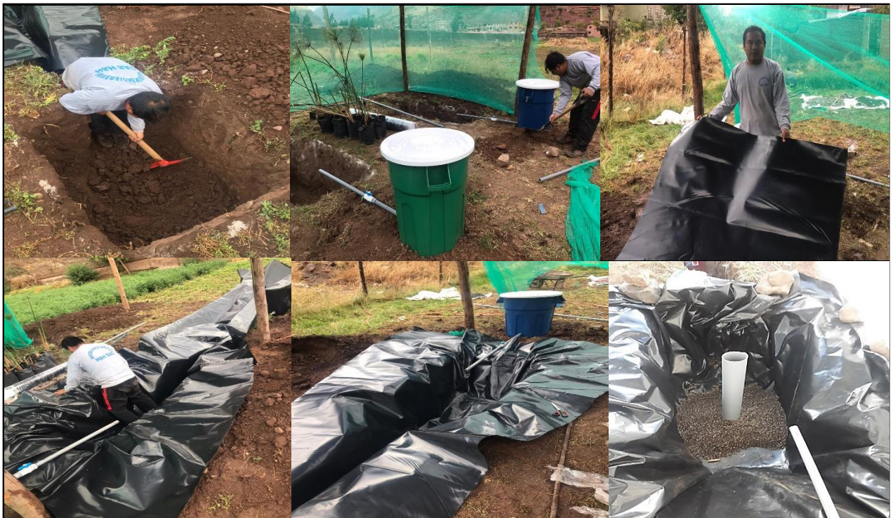
Figura 67. Colocación de la geomembrana HDPE a las dos zanjas de HAFHSS.
