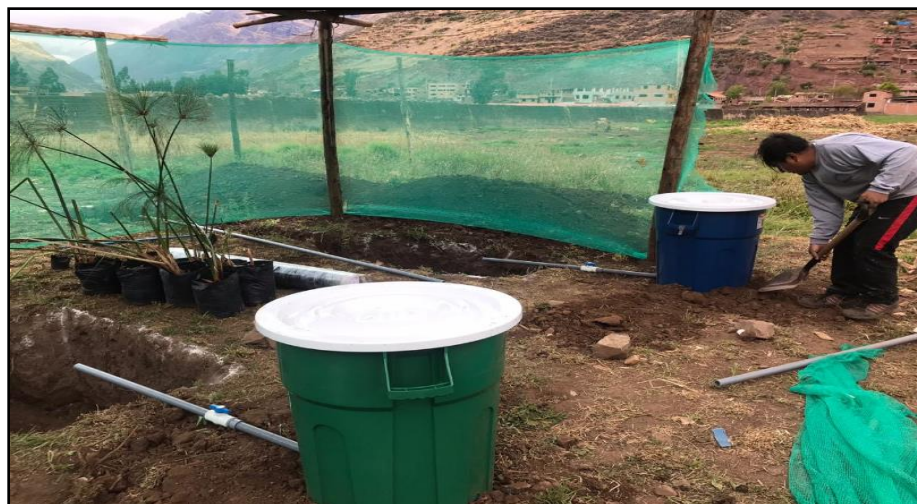
Figura 14. Cilindros de almacenamiento de lixiviados.
