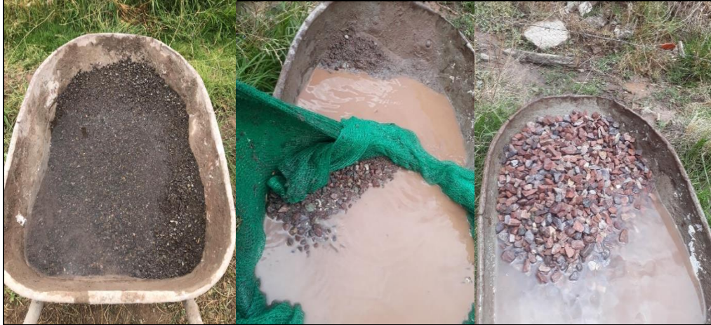
Figura 63. Lavado de sustratos para los HAFHSS
