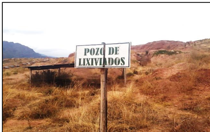
Figura 13. Pozo de Lixiviados del Relleno Sanitario de Urubamba.
