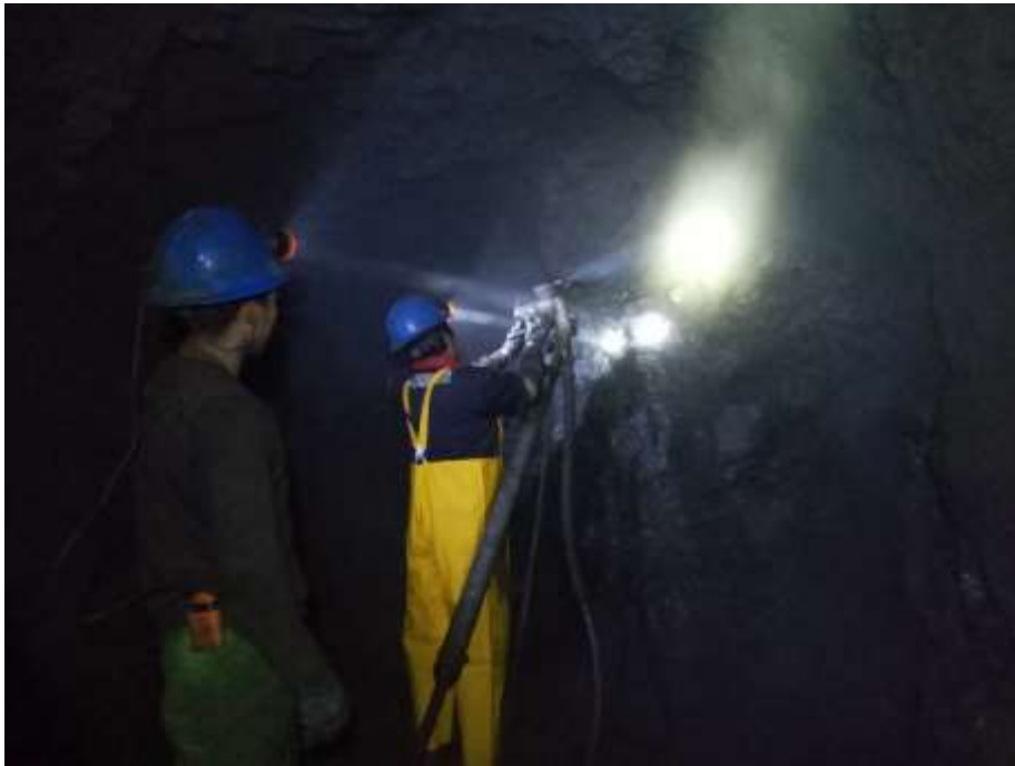
Frente de perforación- actual
