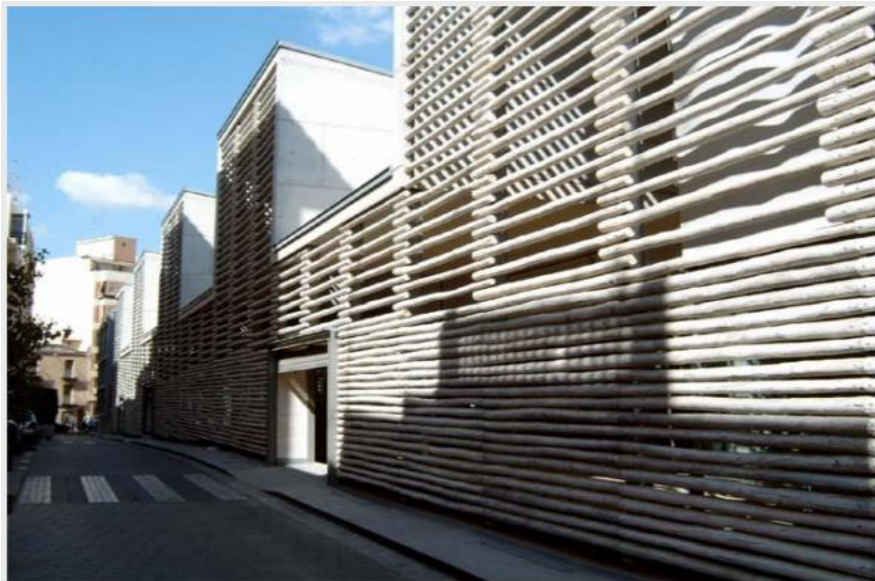
Figura 23. Fachada longitudinal del mercado
