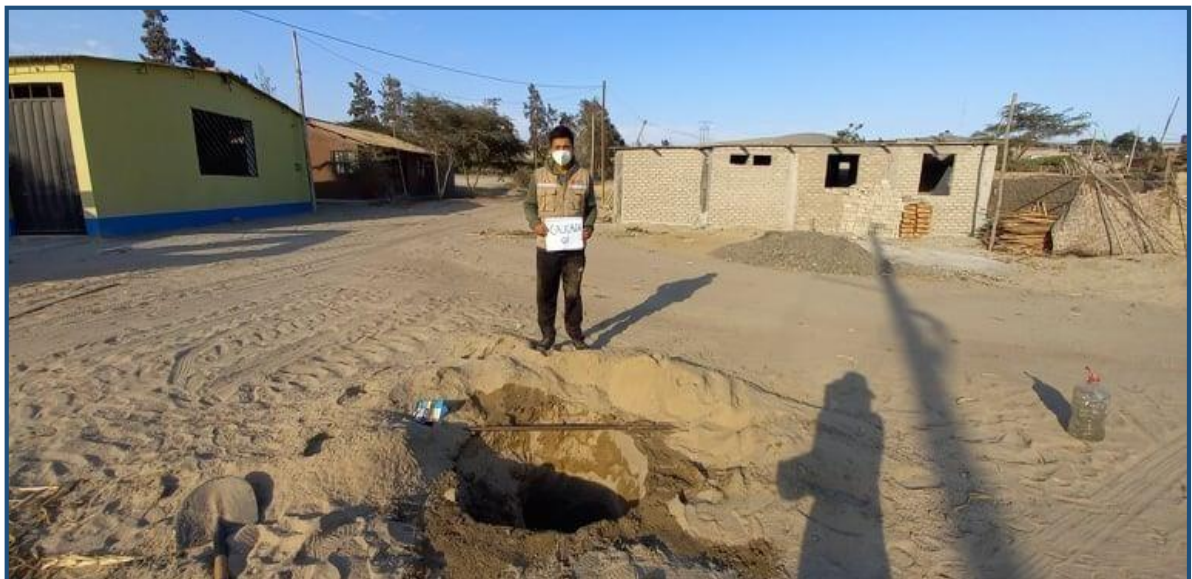
Calicata 2: Línea de Impulsión
