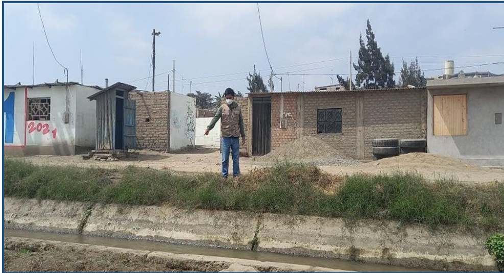
FIGURA N°. 26 PUNTO DE CAPTACIÓN
