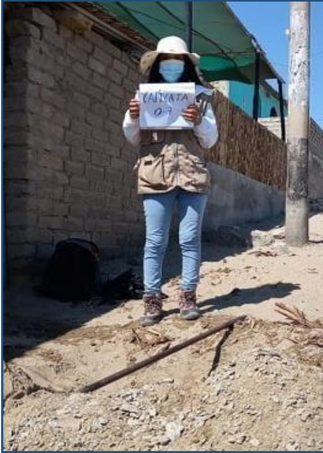
FIGURA N 8 Calicata 7: Redes de Distribución
