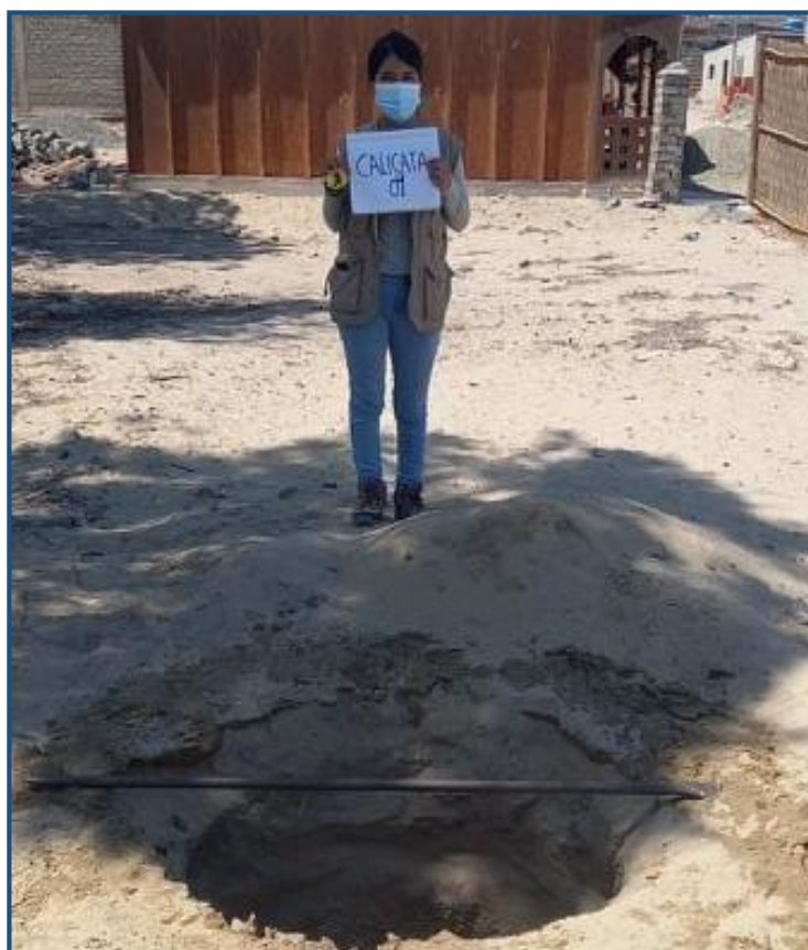
FIGURA N 5 Calicata 4: Redes de Distribución
