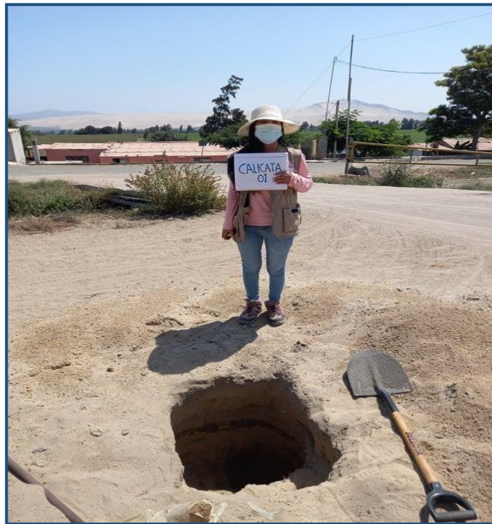
Calicata 1: Redes de Distribución
