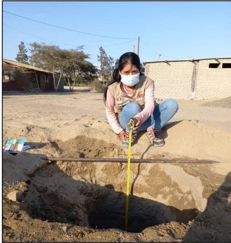
FIGURA N°. 40 ELABORACIÓN DE LAS CALICATAS
