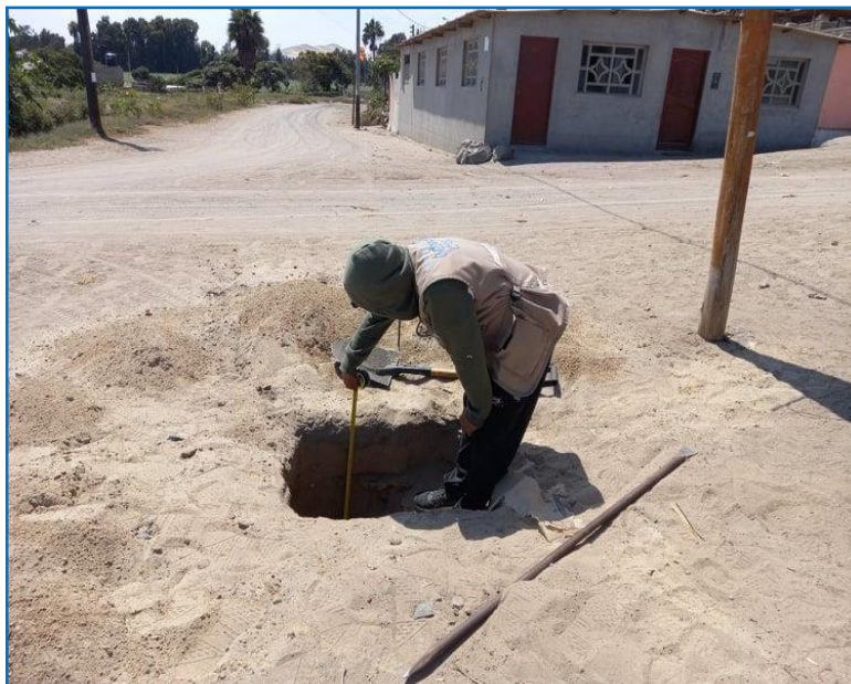
FIGURA N°. 41 ELABORACIÓN DE LAS CALICATAS
