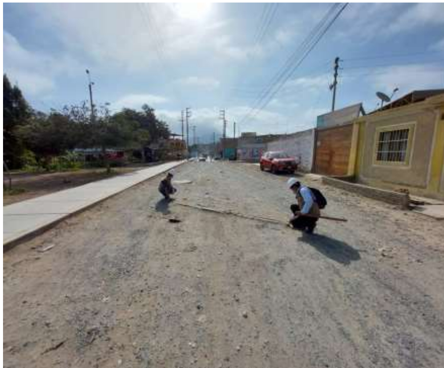
GRÁFICO N°2 – Toma de muestra de desprendimiento de agregados
