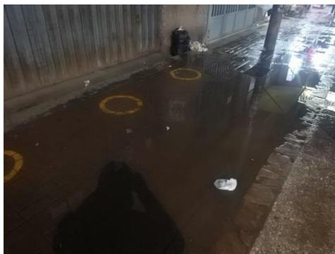
*Nota: la figura 16 y 17 muestra algunos daños y el problema de las alcantarillas que no evacuan las aguas pluviales estancadas en la cuadra 5 del Jr. Moquegua*
