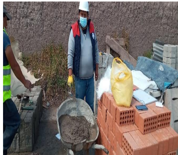
Figura N° 8: Elaboración del Mortero
