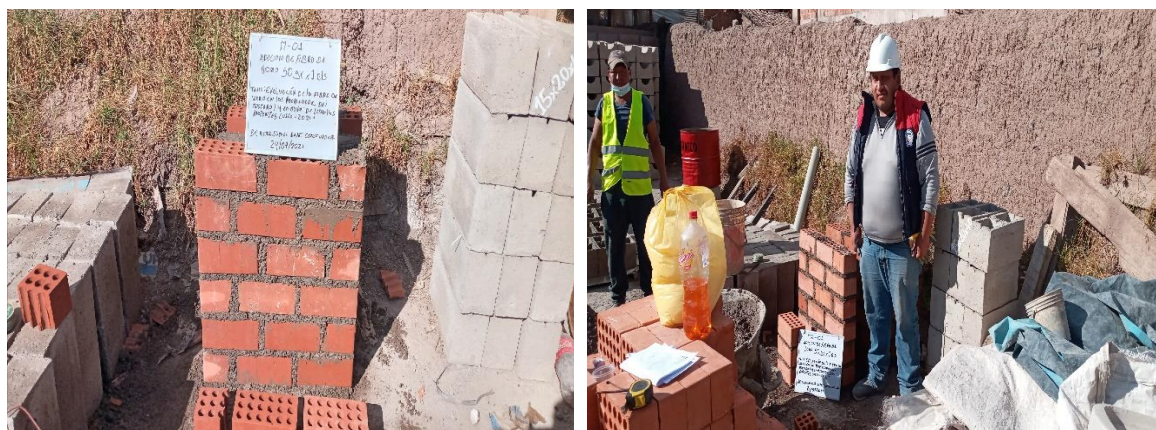
Figura N° 12: Muretes de Albañilería
