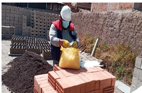
Figura N° 4: Preparado de la Fibra de Vidrio
