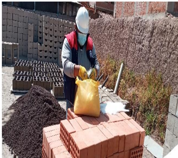
Figura N° 7: Pesado de Fibra de Vidrio
