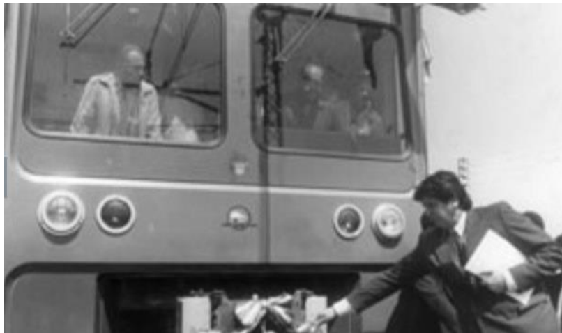
Figura 11 - Alan García inaugurando el inicio de la obra en 1986 Fuente: (La República, 2011)
