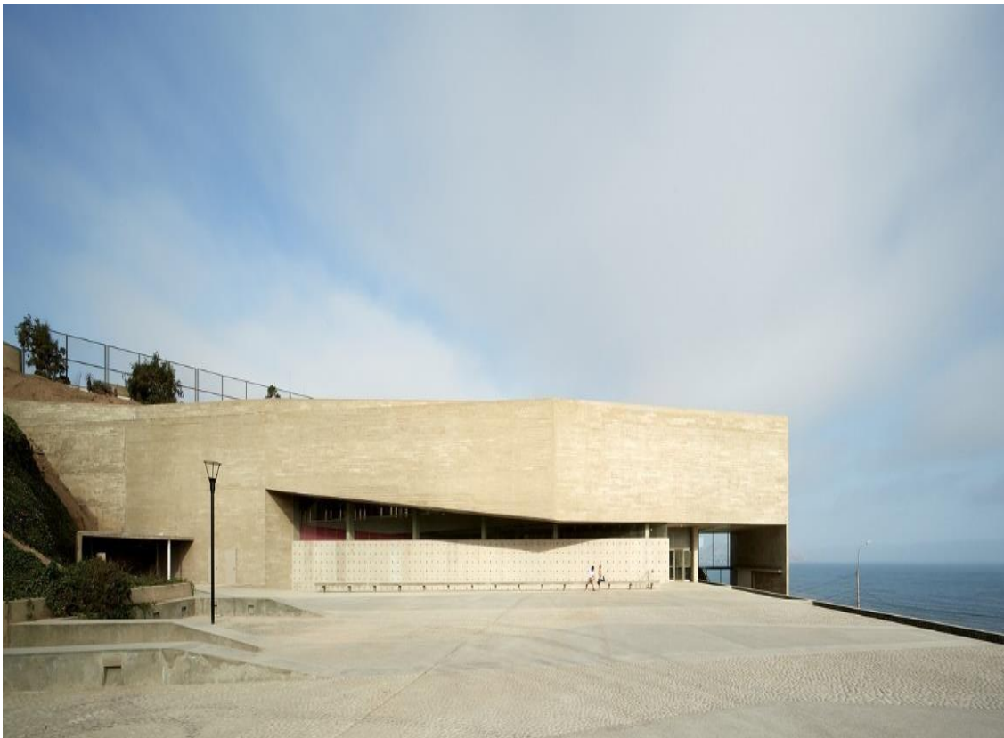
Figura 63 - Vista Lateral del LUM Fuente: Archidaily.pe, 2014
