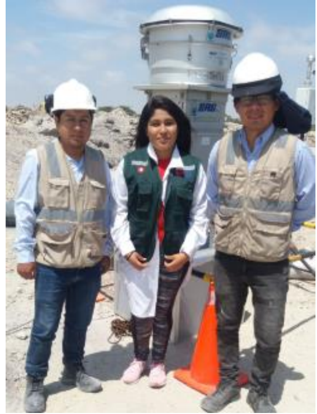
Instalación y funcionamiento del equipo completado.
