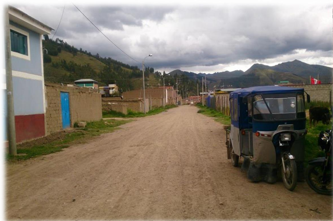
FOTOGRAFIA 04 ESTADO ACTUAL CALLE LOS ROSALES
