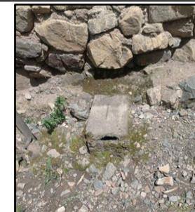
Las cajas de registro de agua potable, como se observa en la imagen esta sobre puesta por un cumulo de desmonte y también invadido por las aguas fluviales que por la parte deteriorada ingresa a la caja de registro de agua potable; también en la otra imagen la tapa de caja de registro esta con rajaduras o un con un agujero en la tapa por lo que está en un estado de deterioro.
