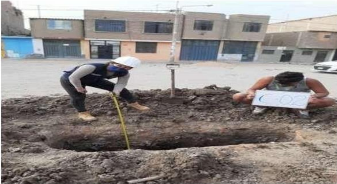
Figura 4. Chiclayo, Profundidad de Calicata N° 02, 2020
