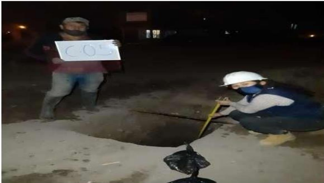
Figura 7. Chiclayo, Calicata N°5 en el Km 5, 2020
