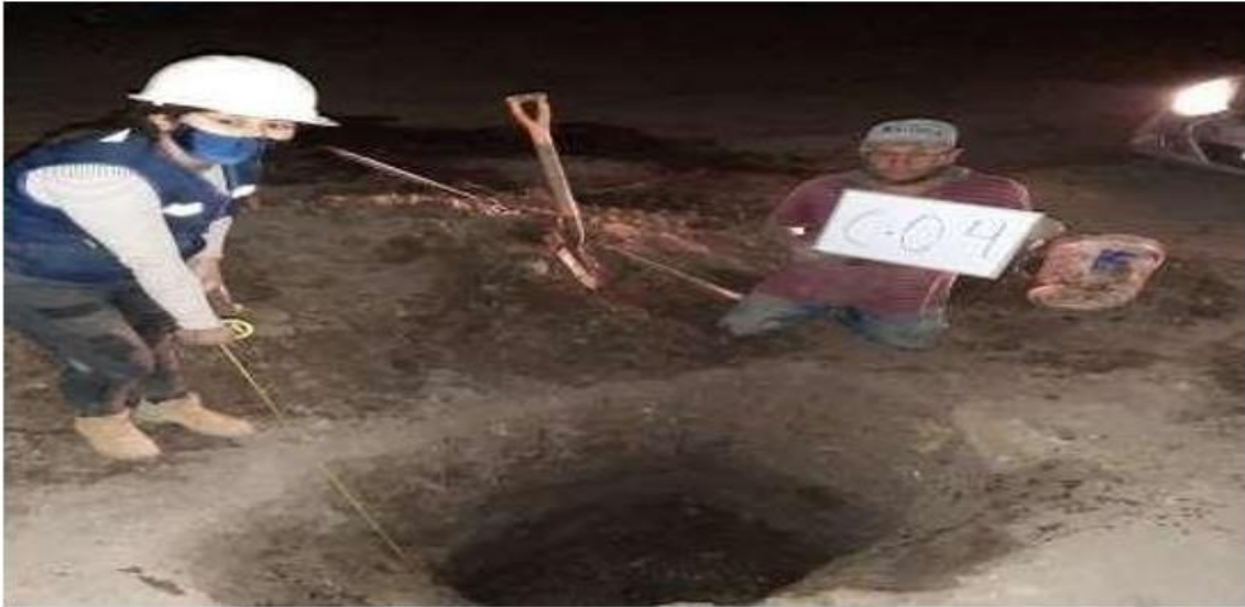
Figura 6. Chiclayo, Alto Relleno natural en Calicata N° 04, 2020
