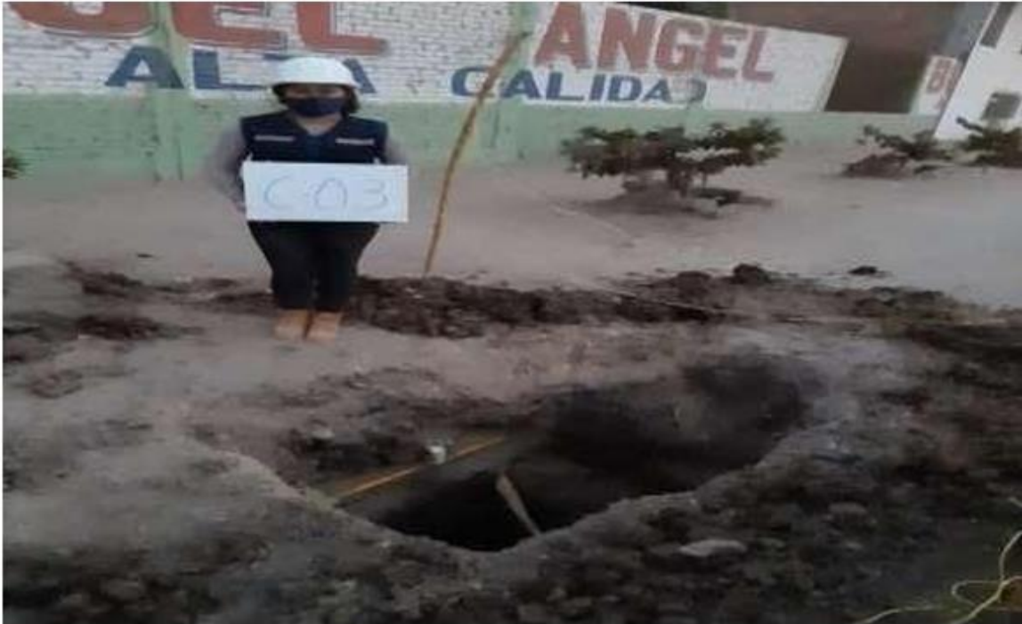
Figura 5. Chiclayo, Profundidad de Calicata N° 03, 2020
