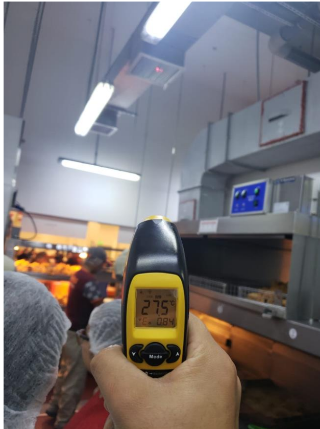
Figura 27. Medición del sistema de inyección Fuente: Propia
