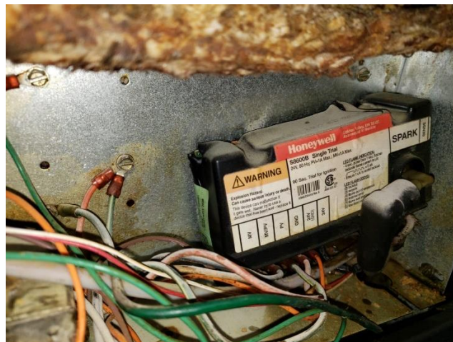
Figura 53: Módulo de ignición recalentado Fuente: Elaboración Propia
