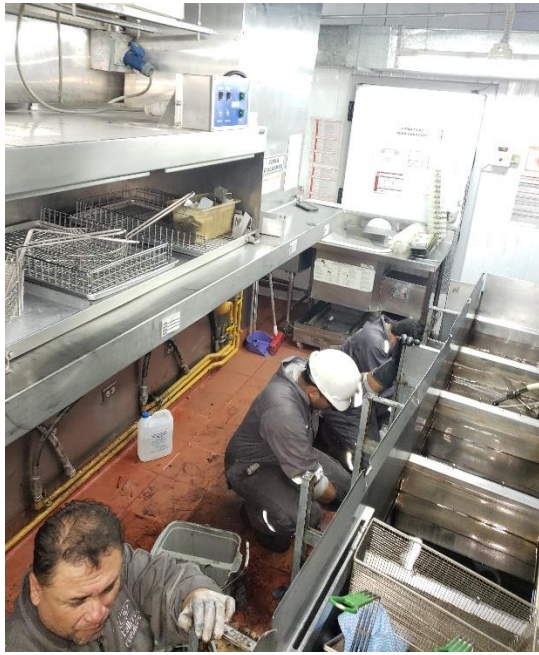
Figura 39.Mantenimiento Preventivo vista posterior de freidora Fuente: Elaboración Propia
