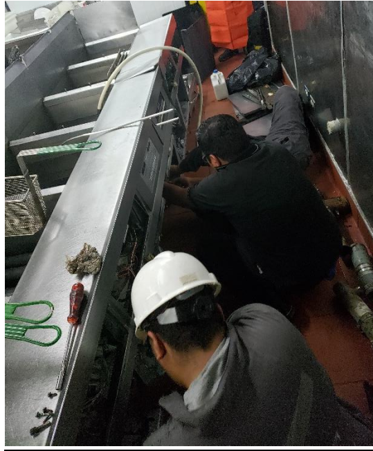
Figura 38.Mantenimiento Preventivo vista frontal de freidora Fuente: Elaboración Propia
