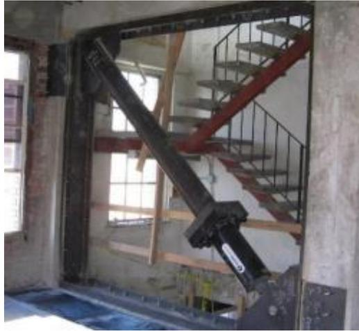
**Figura 5:** Disposición diagonal típica de un disipador.
