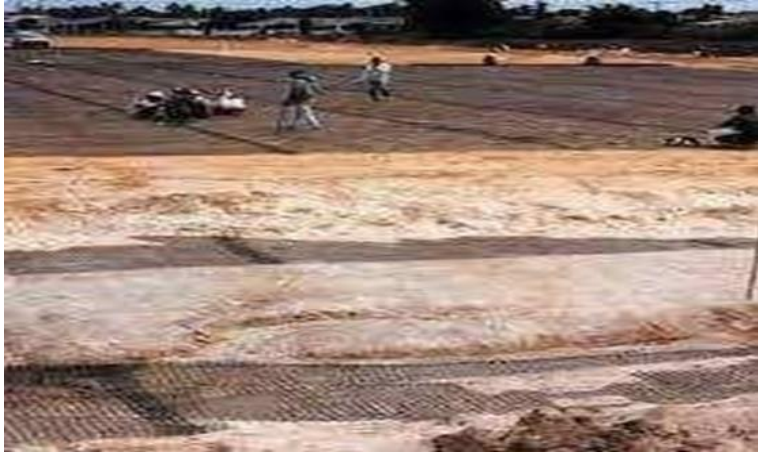
Figura 8. Estabilización y consolidación
