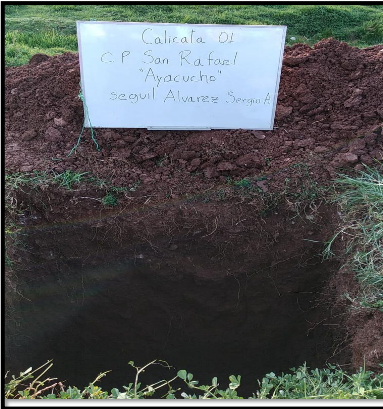
Realización de calicata en el centro poblado San Rafael.
